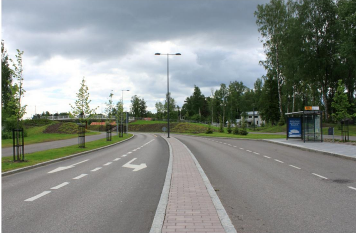
Kuva 36. Kuva laadukkaasti Espoossa toteutetusta kadusta, Lintulaaksontiestä (kuva: Espoon katupoikkileikkausten suunnitteluohjeen päivitys, Espoon kaupunki 2010)
