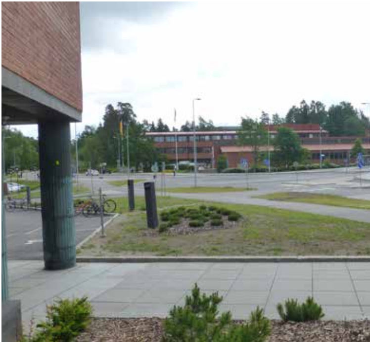
Aluejulkisivu kuvattuna Aalto-yliopiston kirjastolta kohti Kivimiehen aluetta. Risteyksialue on kaupunkikuvallisesti merkittävä hierarkkinen piste ja sen rooli tulee todennäköisesti tulevaisuudessa korostumaan.
