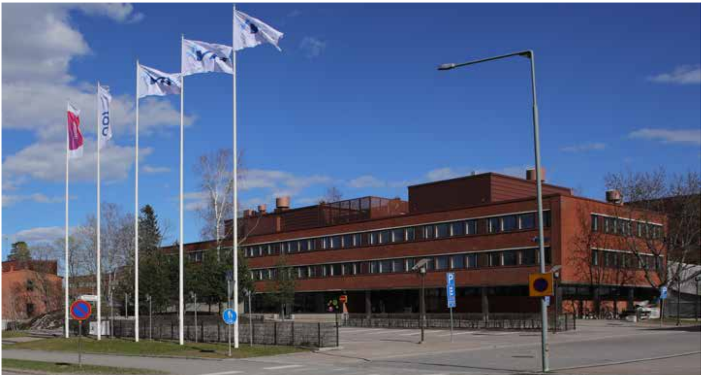
Vuorimiehentie 5, silloinen VTT:n päärakennus kuvattuna vuonna 1977 (VTT Oy) sekä vuonna 2017. Rakennus on hyvin säilynyt, ja siinä on kuten monissa muissa Kivimiehen alueen rakennuksissa on tehty ainoastaan vähäisiä ulkoisia muutoksia. Katolle on lisätty ilmanvaihtokonehuoneita ja etuosan betonipilarit on päällystetty metallilevyllä. Pihajärjestelyt ovat pysyneet peruspiirteiltään samana pysäköintialueineen ja nurmikenttineen.
