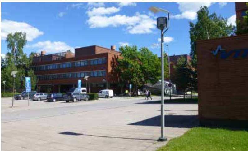
Ympäristörakentaminen on hyvin vaihtelevaa. Katutila yhdistyy tässä paikoitusalueeseen sekä laatoitet- tuun aukioon. Paikoitusalueet on rajattu leikatuilla pensasaidoilla. Kuva on Vuorimiehentie 3:en edustalta kohti Vuorimiehentie 5 rakennusta.
