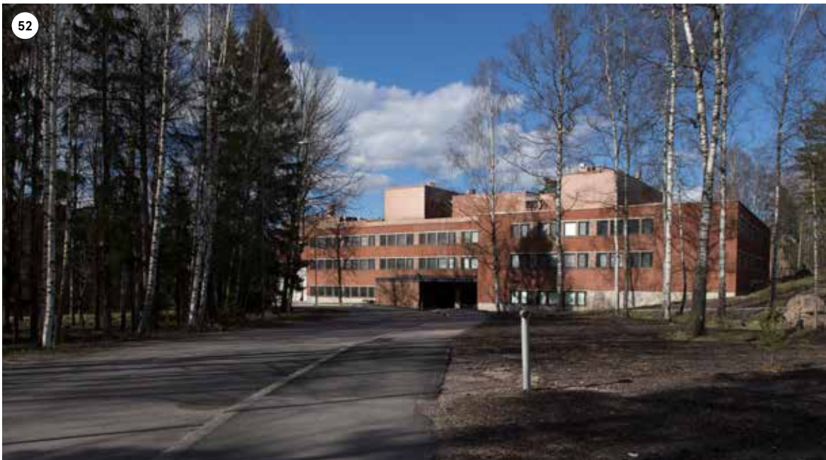
Vuorimiehentie 5 rakennettiin alun perin VTT:n päärakennukseksi vuonna 1975. Rakennus on mielenkiintoisesti massoiteltu ja istutettu maastoon. Rakennusta on kutsuttu nimellä Päärakennus tai Päätalo.
