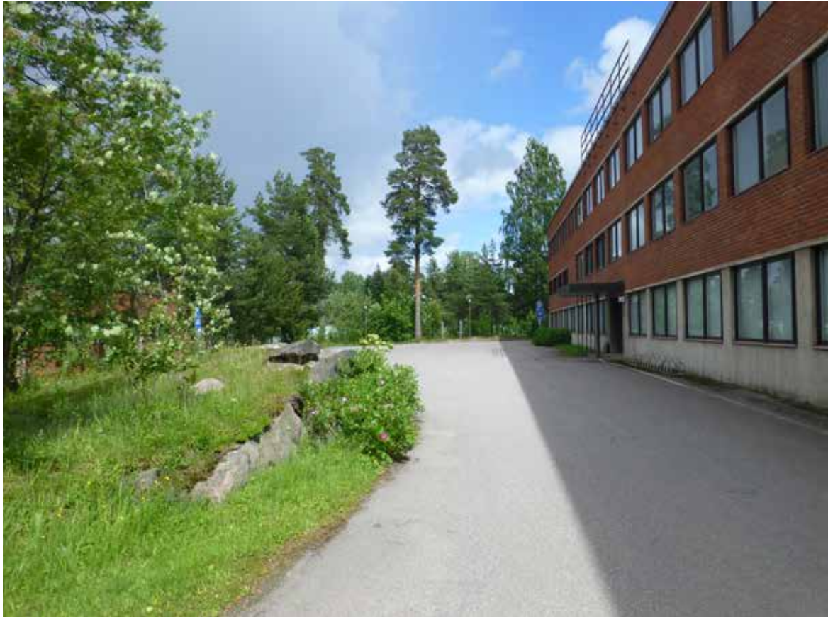
Kivimiehen alueen tyypillisiä ominaispiirteitä ovat näyttävät yksittäiset männyt ja mäntyryhmät, paikoitellen avokalliot sekä rakennusten väliin jäävät asfaltoidut huoltopihat.
