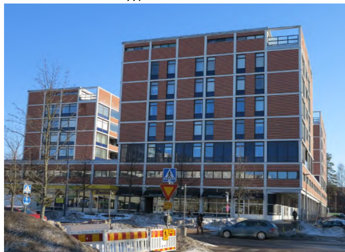
Kuunkehrän aukion eteläreunaan sijoittuvaan hybridirakennukseen liittyy pysäköinti-, liike-, toimisto- ja palvelutiloja sekä näiden päältä nousevat kolme asuintornia. Arkkitehtuuriltaan rakennus noudattaa alueelle ominaisia ratkaisuja.
