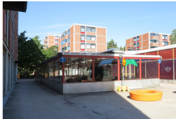
Olarin ostoskeskus, talvipuutarhan lasirakenteinen yläosa
