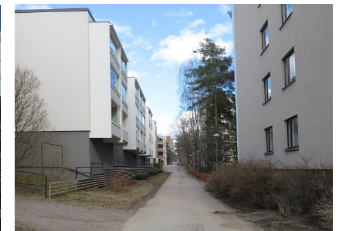
Kuutamaisen varrella sijaitsevat 3-kerroksiset lamellitalot ovat myöhemmin saaneet lämpörappauksen. Maantasokerros on umpinainen eikä avaudu raitin suuntaan.
