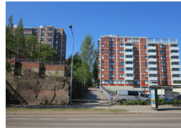
Alueelle ominaiset kalliroleikkaukset korostuvat alueen reunalla Olarinkadun katukuvassa.
