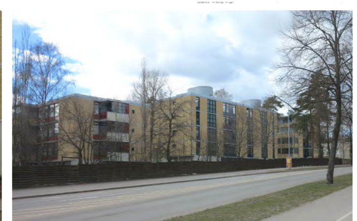
Kortteli hahmottuu Olarinkadun suuntaan muurimaisena rakenteena.
