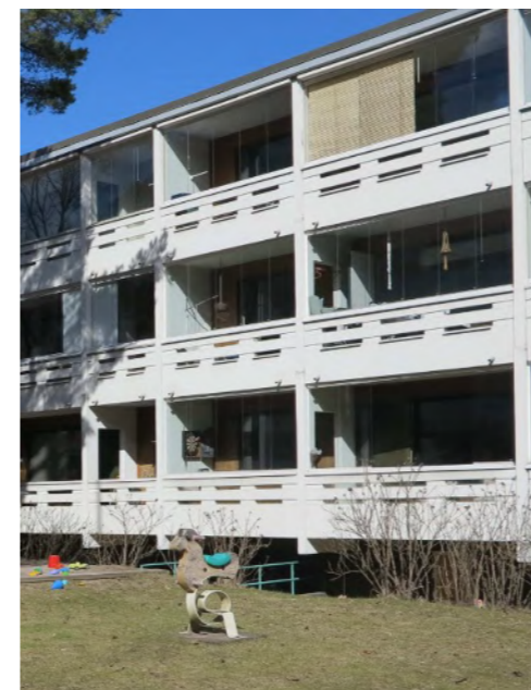
Puolimatkan korttelin 22039 ulokerakenteena toteutetuissa parvekkeissa on aukotuksin kevennetty betonikaide. Sivuseinämät on tuettu rungosta.
