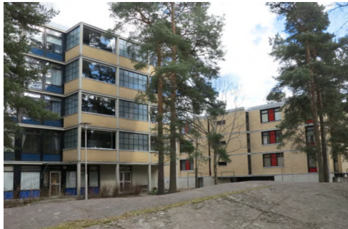
Kuitinmäki I alueen kaakkoiskulman korttelin julkisivuissa on poikkeuksellisesti käytetty keltaista tiiltä. Julkisivun jäsentely ja värikkäät julkisivulasit, sekä vaakajakoiset tummapuutteiset ikkunat ovat alueelle tyyppisiä.
