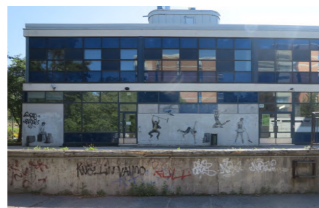
Katutaiteella ehostettu pohjoisen liikerakennuksen läntinen julkisivu.
