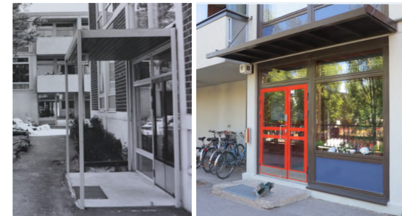
Teräs-lasi-rakenteisten ulko-ovien ikkunajako sovitettiin alkujaan julkisivujaotuksen mukaan. Olarin aloituskortteliin toteutettiin kevyet pilarein tuetut katokset. Valokuva vasemmalla korttelista 22045, Simo Järvisen arkisto / AM.
