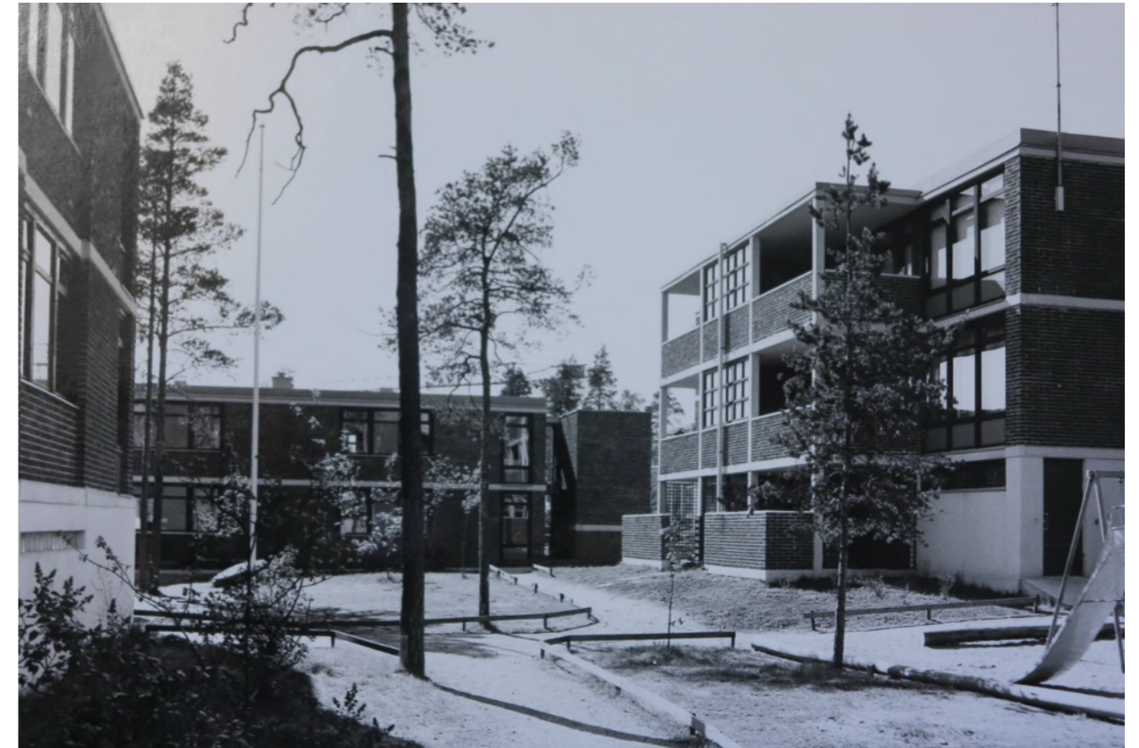
Alkuvaiheen valokuva korttelin 22047 pihalta. Pienkerrostalokorttelissa sijoittuu asuntoja myös maantasokerokseen. Maaston alkuperäiset muodot ja puusto on pyritty säilyttämään. Kuva Mattiveikko Salo/ AM.
