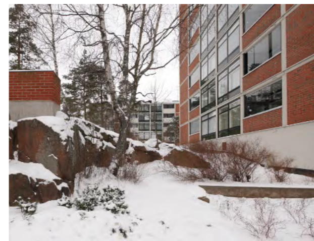
Avokalliot tiilimuureineen muodostavat vahvan maisemallisen elementin. Myöhemmin lasitetut sisäänvedetyt parvekkeet sulautuvat julkisivupintaan.
