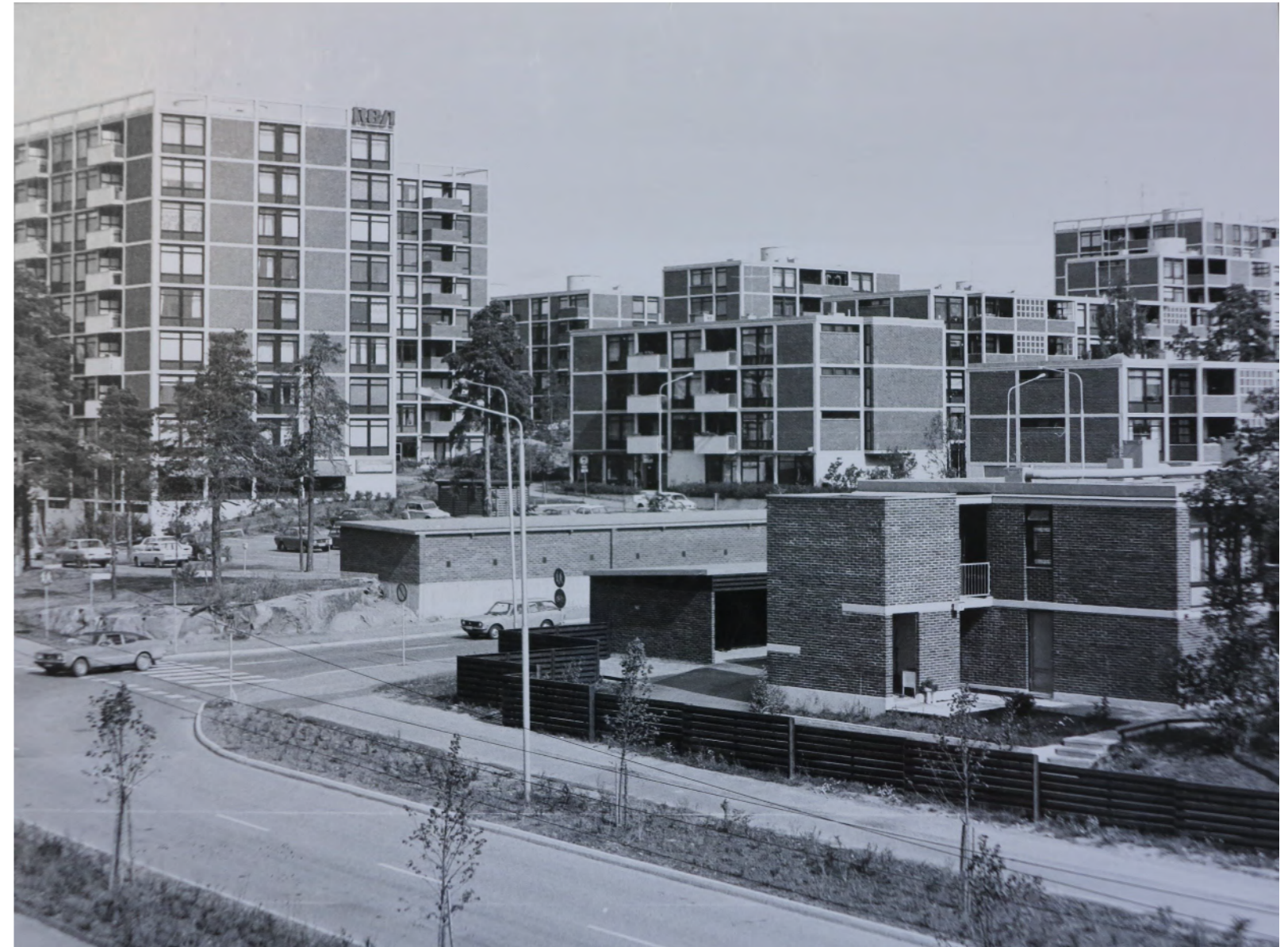
Olarin alue lounaasta kuvattuna. Vaihtelevan korkuiset samaan ruutujakoiseen julkisivujäsentelyyn perustuvat rakennukset muodostavat kaupunkikuvassa eheää ja samalla tilallisesti vaihtelevaa ja elämyksellistä ympäristöä. Kuva AM
