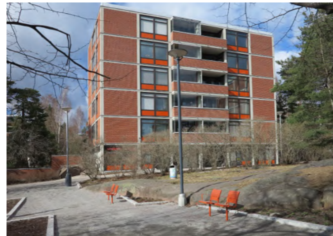
Myös raitin varren viisikerroksiset talot ovat yhden lamellin pistetaloja. Korttelissa 22034 on parvekkeet toteutettu osittain sisäänvedettyinä ja tiilipintaisin kaitein.
