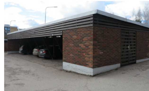
Korttelissa 22047 on pysäköintikatos jätehuoneineen toteutettu osana edustavaa korttelikokonaisuutta.
