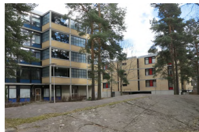
Pihan julkisivuissa on runsaasti ikkunapintaa. Parvekkeiden alkuperäisiä lasitiiliseiniä on myöhemmin täydennetty silein lasituksin.
