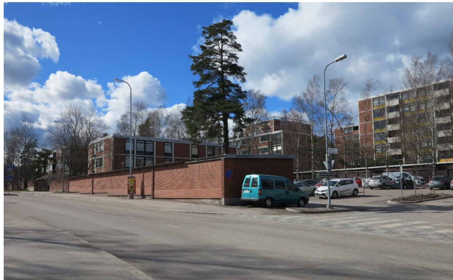
Ruomelantien varren pysäköintikorttelit on kadun suuntaan rajattu muurimaisesti punatiilisin autotallein. Ratkaisu on osa kaupunkikuvallista kokonaisuutta.
