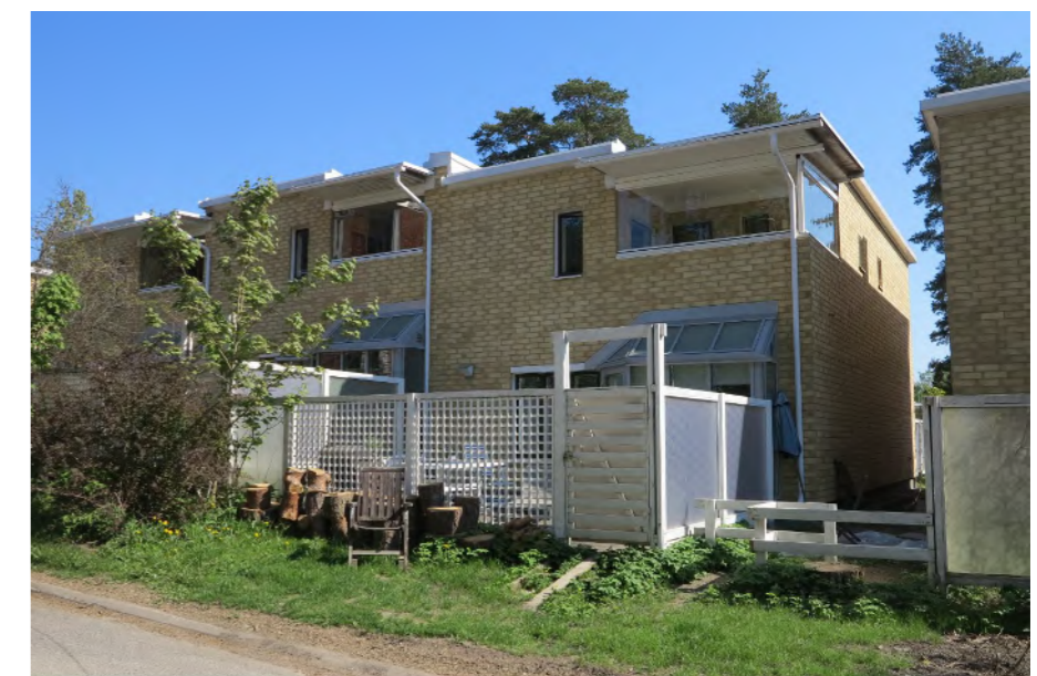
Rakennukset muodostavat kaupunkikuvassa muurimaista polveilevaa rakennetta, jossa korostuu julkisivussa käytetty kirjavankeltainen tiili. Rakennusten ilmettä on jonkin verran muuttanut parvekkeiden myöhemmin muutetut katokset ja lasitukset sekä viherhuoneiden muuttuneet yksityiskohdat.
