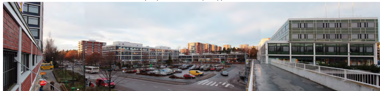
Kuunkehrän aukio vuonna 2012. Oikealla näkyy myöhemmin purettu Esson entinen pääkonttori, vasemmalla aukion eteläreunassa sijaitseva hybridirakennus, jossa edelleen toimii alueen tärkeä päivittäistavara-kauppa. Kuva Livady.
