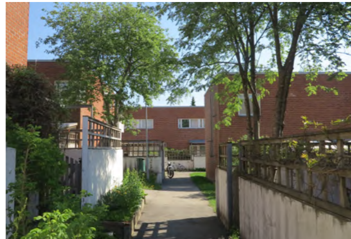
Planeetankadun pohjoispuolella on arkkitehtuuriltaan kiinnostava tiivis kaksikerroksisten pienkerrostalojen kortteli.
