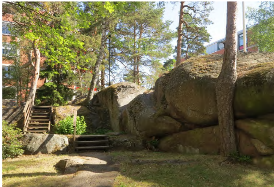
Olarin kortteleissa liittyy kalliomaastoon sovitettujen pihojen polkuihin mm puurakenteisia portaita. Vanhoista valokuvista päätelleen kuuluvat portaat ainakin osassa pihajoja alkuperäisiin ratkaisuihin. Kuva korttelista 22035.
