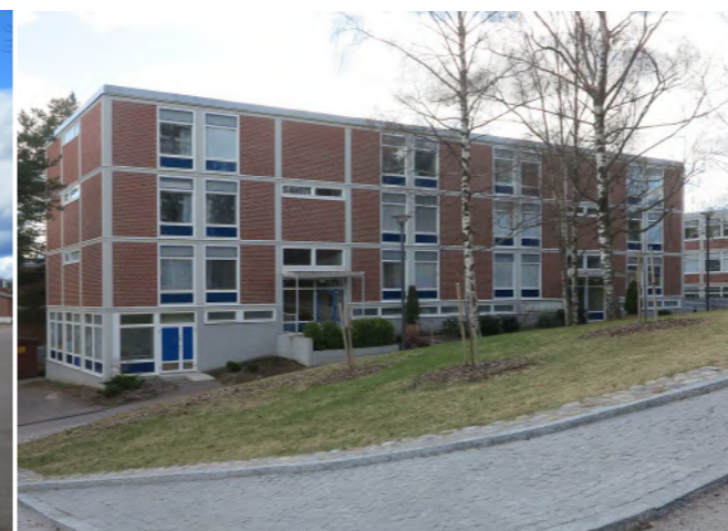
Tasakattoiset rakennukset ovat massoitteeltaan kappalemaisista ja julkisivujen jäsentelyltään korttelissa 22044 symmetrisiä. Kiinnostavuutta tuovat maantasokerroksen porrastukset ja niihin liittyvät suurilla ikkunapinoilla varustetut liiketilat.
