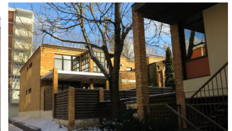
Kuitinkadun julkisivuja ja piharakenteita.
