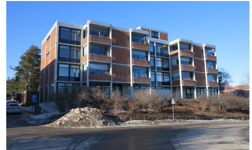
Kuitinmäen eteläisimmässä ja viimeisimpien joukossa valmistuneessa korttelissa 22120 toistuvat edelleen jo Olarin alkuvaiheissa käytetyt julkisivuaiheet; ruutuja-tyyppi, värilasit ja punatiliipinnat. Nurkkapilarein tuetut parvekkeet ovat uusi myöhemmin Kuitinmäen alueella yleistynyt aihe.
