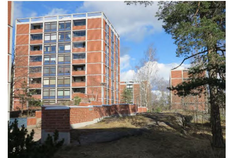
Alueelle ominaisiin pistetaloihin liittyy katolla kehikkorakenne.
