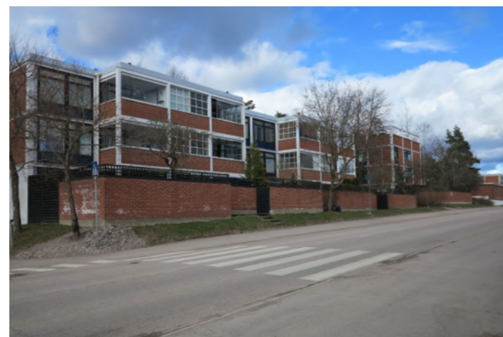
Ruomelantien varressa rajaa asuntopihoja tilimuuri. Parvekkeet on toteutettu vaihtelevasti, joko osittain sisäänvedettyinä tai kokonaan julkisivun ulkopuolelle sijoittuvina pilarein tuettuina parvekeryhminä. Kuva korttelista 22041.
