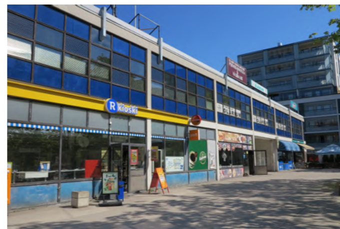
Kuitinmäen ostoskeskuksen pohjoisreunan rakennus
