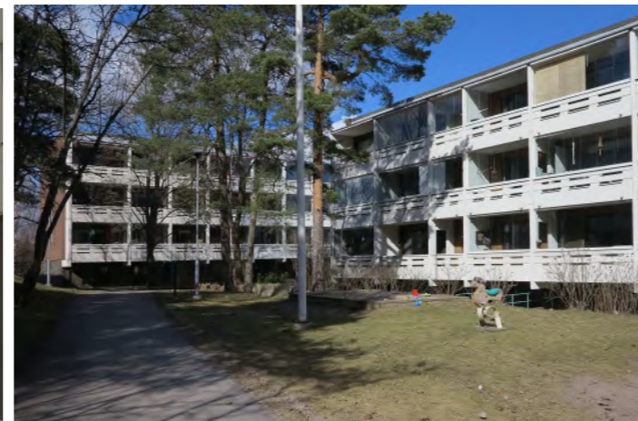
Korttelissa 22039 on julkisivujen jäsentely 1960-luvulla tyypillisen tapaan nauhamainen. Parvekkeiden taustaseinät ovat vaneripintaisina, nykyään kauniisti eri sävyin kuultokäsiteltyjä. Valkeat aukotuksin kevennetyt betonikaiteet muodostava väripinnoille raikasta kontrastia. Pihoille antaa erityistä luonnetta kalliopinnot, siirtolohkareet ja mäntypuusto.
