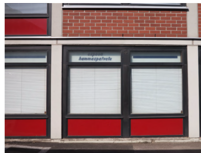
Vasemmalla: korttelin 22037 puistonpuoleisessa rakennuksessa on sisäänvedetty suojaisa terassimainen ulkotila. Oikealla: Korttelissa 22035 raitin suuntaan on pohjakerroksissa suuria lasipintoja.
