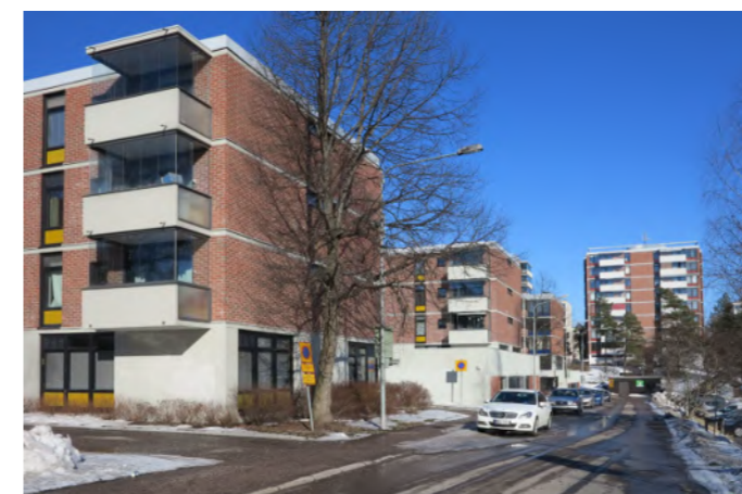
Kuitinmäessä on parvekkeet toteutettu betonirakenteisina ulokeparvekkeina. Julkisivulaseja on myöhemmin korvattu levyillä. Kuva Kuunsäteen kadulta.
