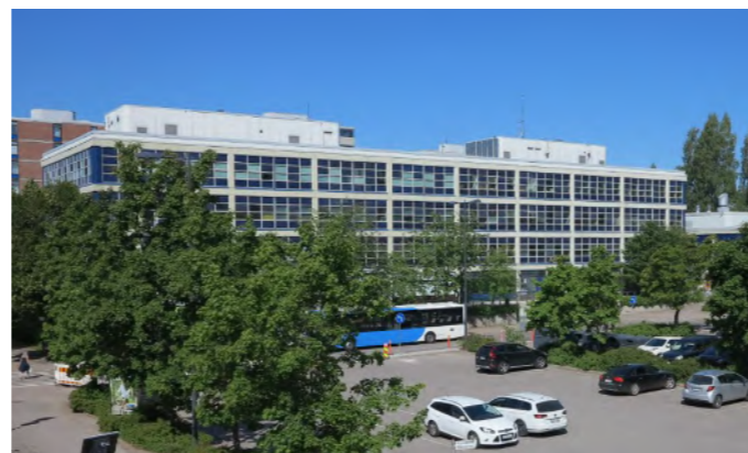
Kuitinmäen ostoskeskuksen länsireunan rakennus
