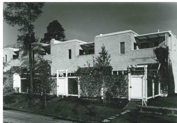
Alkujaan parvekkeisiin liittyi vain osittain suojaava valokate ja viherhuoneiden rakenteet olivat nykyistä sirorakenteisempia. Pihoja suojaavat aitarakenteet kuuluivat alkuperäiseen ratkaisuun. Kuva Simo Järvisen arkisto/ AM.
