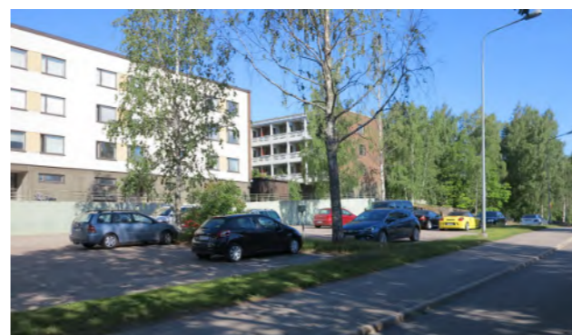
Olarin itäreunan pysäköintikorttelin ja kadun välissä ei ole istutuksia. Pysäköintialue sijoittuu selvästi asuinkortteleita matalammalle tasolle.
