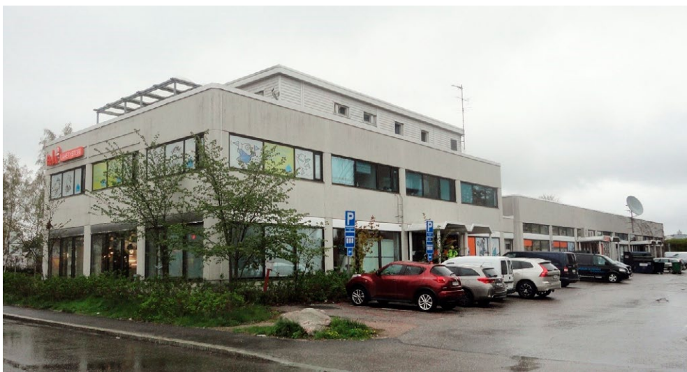
Rakennuksen sijainti Merituulentien väyläympäristössä antaa sille toimilarakennuksen luonteen.
