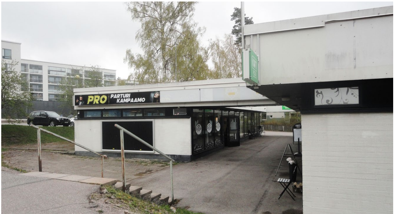
Ostoskeskuksen läpi kulkee katettu ulkokäytävä.
