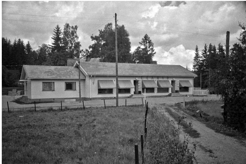
Espoon Tuomarilan, 25.7.1950 avattu, Elannon myymälä uutena. Myymälän päädysssä on myymälänhoitajan asunto. Rakennus on sittemmin purettu. (Helsingin kaupunginmuseo)
