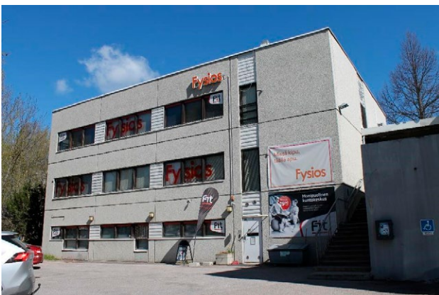
1980-luvun lopulla toteutettu laajennusosa poikkeaa arkkitehtuuriltaan alkuperäisestä rakennusosasta.
