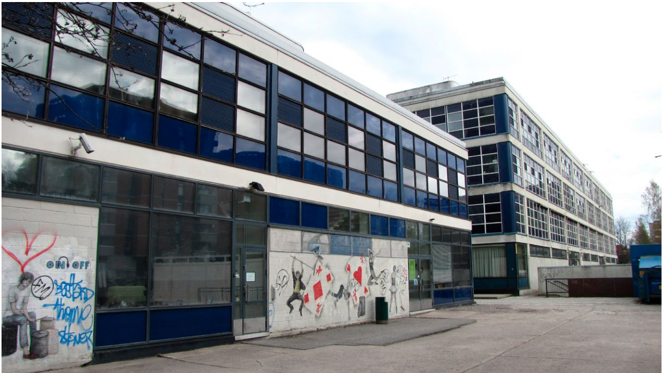
Kuitinmäen ostoskeskus valmistui osissa vuosina 1973, 1975, 1977, 1983 ja 1985. Vuosien 1973-1983 aikana valmistuneet kokonaisuudet on suunnitellut Arkkitehtuuri- ja sisustusarkkitehtitoimisto Järvinen-Valjakka. Myöhäisimmän osan ostoskeskuksesta on suunnitellut Puolimatka-yhtymä Oy:n arkkitehtuuriosasto.
