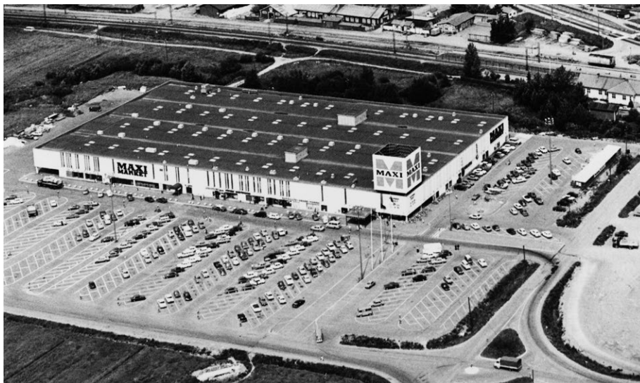
Espoon Leppävaarassa aloitti toimintansa vuonna 1970 Maxi-market. Suurikokoista, tasakattoista ja matalaa liikerakennusta reunustivat laajat pysäköintikentät. Rakennuksen tunnusmerkkinä oli sen katolla seisonut suuri kuutionmuotoinen mainosvalo . (Espoon kaupunginmuseo, kuvaaja Atte Matilainen)
