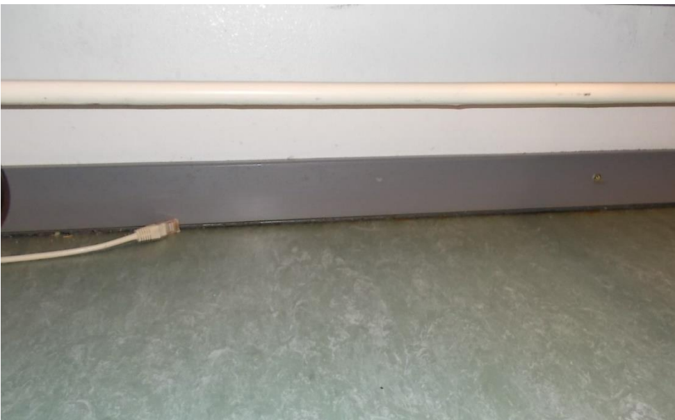
Kuva 4.6. Seinän ja lattia liittymä Luokassa 239.
