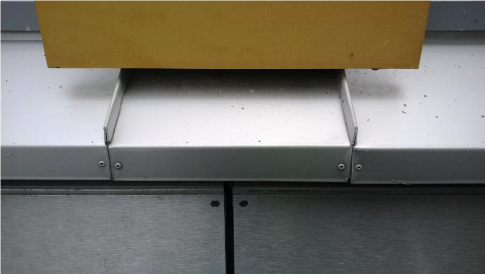
Kuva 4.9. Tuuletusikkunan rakenne ulkoa päin.
