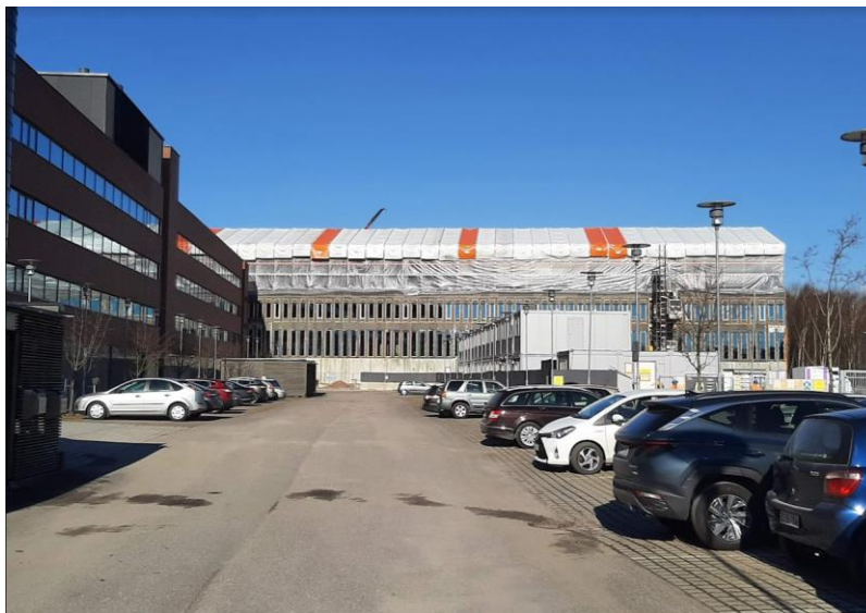
Kuva: Laajennusosan rakentaminen käynnissä. Kuvattu 28.4.2021.
