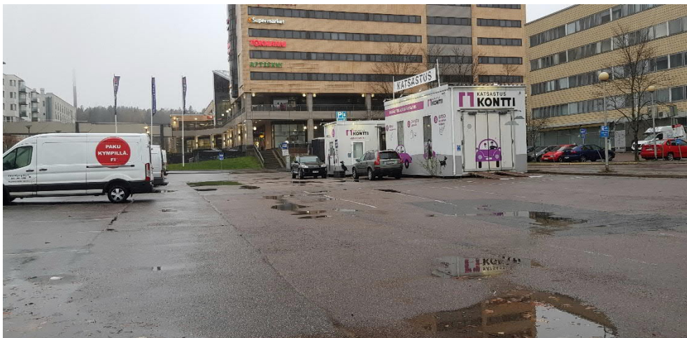
Kuva 3. Rakennuspaikan nykytilanne, taustalla Espoontorin kauppakeskus ja oikealla purettava toimistorakennus.
