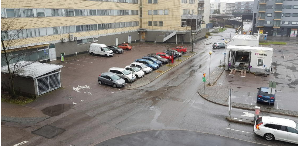
Kuva 2. Rakennuspaikan nykytilanne, vasemmalla purettava toimistorakennus.
