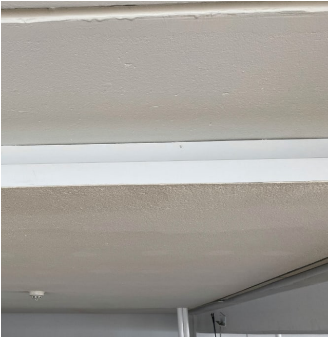
Ensimmäisen kerroksen alakatto.
