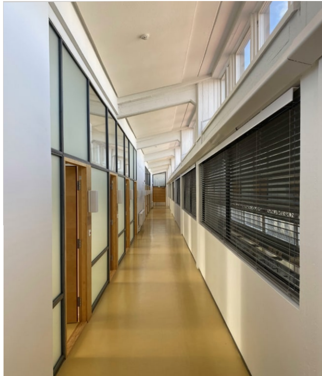
Vuoden 2004 peruskorjauksessa on rakennettu kuvassa vasemmalla näkyvä lasiseinä ja oikealla näkyvät sisäikkunat.
