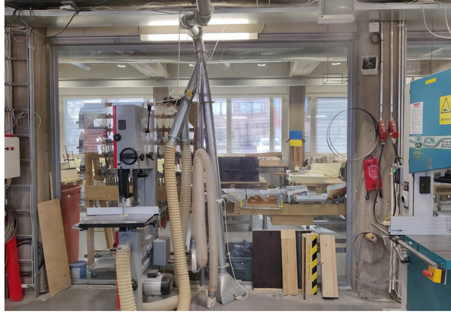
Pajojen ja kokoonpanotilan välissä on uudet teräslasiseinät.
