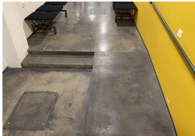
Vanhan varaston oven kohdalla oleva tasoero, nousuun portas sekä ramppi.
