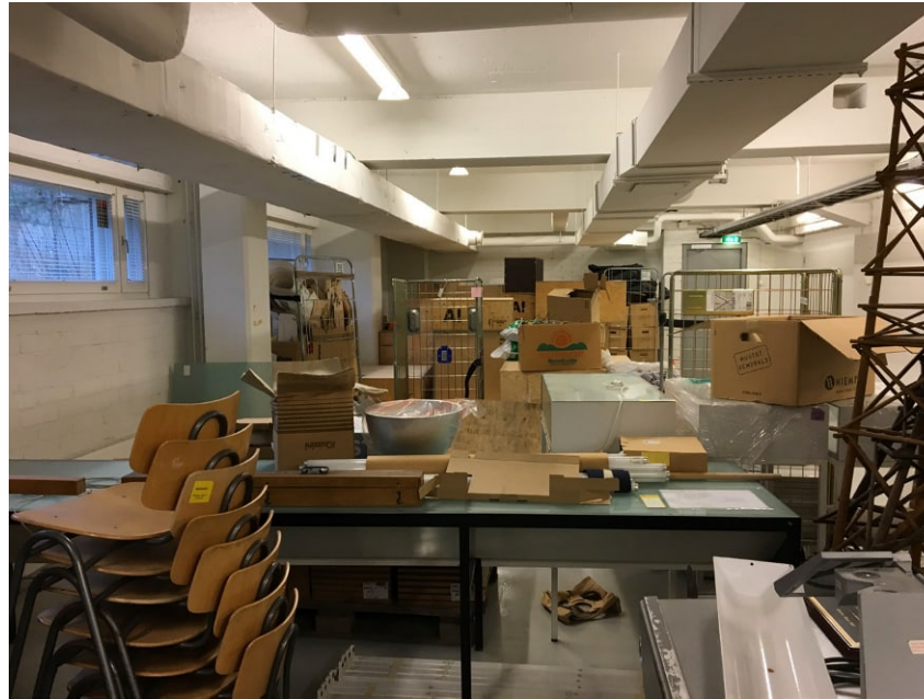
Ensimmäisen kerroksen varastoa tyhjenetään ennen muuttamista grafiikan opetustilaksi. Kuva: Rakennuslupa 49-2018-207 / ERakvv.
