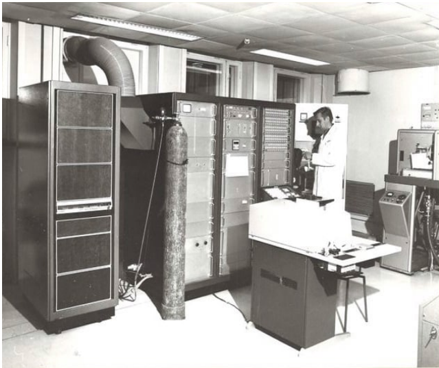
VTT:n vuonna 1960 hankkima Quantovac-tyhjiöspektrometri metallurgian laboratoriossa vuonna 1974. Kuva: VTT:n arkisto.
