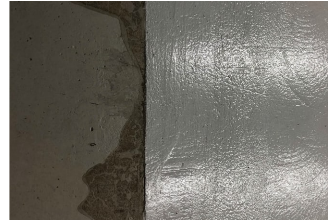
Grafiikan painosalin ja käytävän välillä vaihtuu lattian pintamateriaali. Oikealla painosalin ja vasemmalla käytävän lattia.
