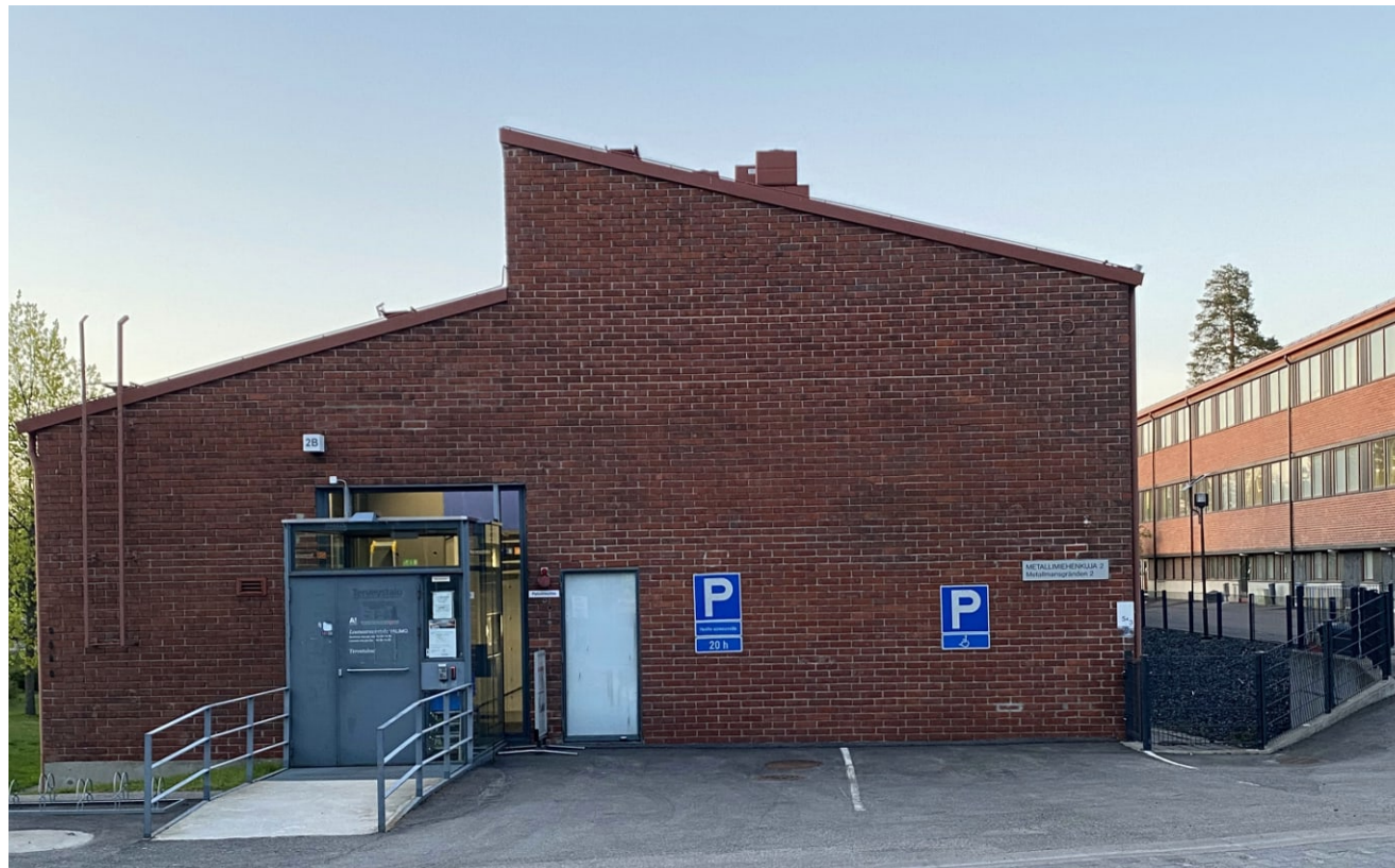
Lounaanpuoleinen sisäänkäynti, ramppi, sekä paikkoja pyörille ja autoille.
