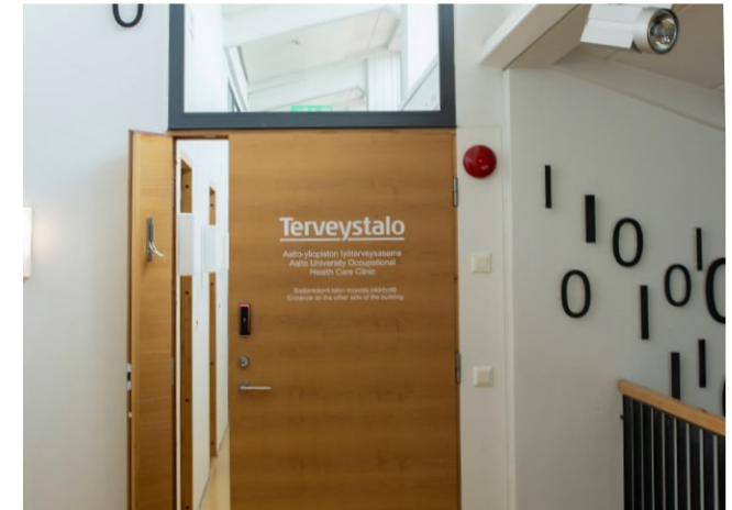
Aulan ja käytävän välinen puinen palo-ovi on vuodelta 2004.
