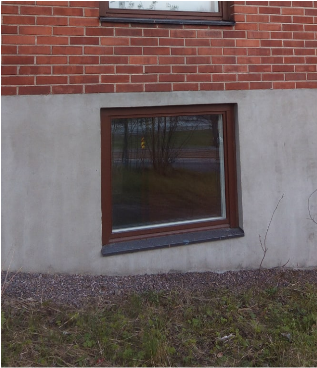
Koillispäädyn ensimmäisen kerroksen ikkuna eroaa muodoltaan rakennuksen muista ikkunoista.
