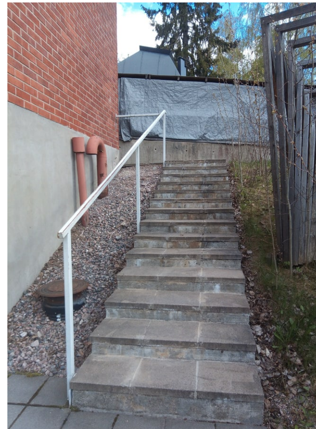
Huoltopihalle vievät betoniset ulkoportaat ja huoltopihan tukimuurit ovat vuodelta 2005.
