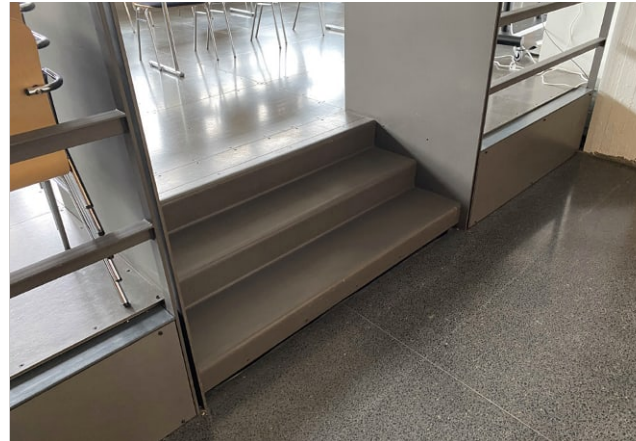
Tilaan johtavien, samasta levystä valmistettujen portaiden askelmat ovat myös kulmistaan pyöristettyjä.
