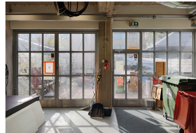
Toisen kerroksen aidatulle pihalle johtavat ulko-ovet on uusittu vuonna 2005.
