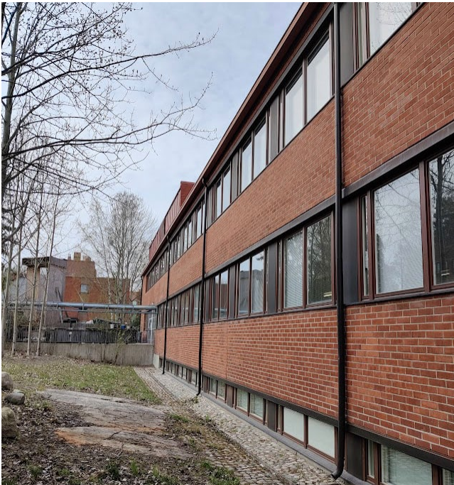
Kaakkoisjulkisivun syöksytorvet. Taustalla näkyy toisesta kerroksesta johtava iv-putki purunpoistokonehuoneeseen.
