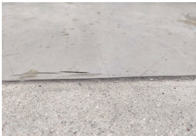
Pääasiassa metallipajan lattiamateriaalina on toisen kerroksen tiloille tyypillinen harmaa epoksi. Alempana näkyy tulityötilan betonilattia.
