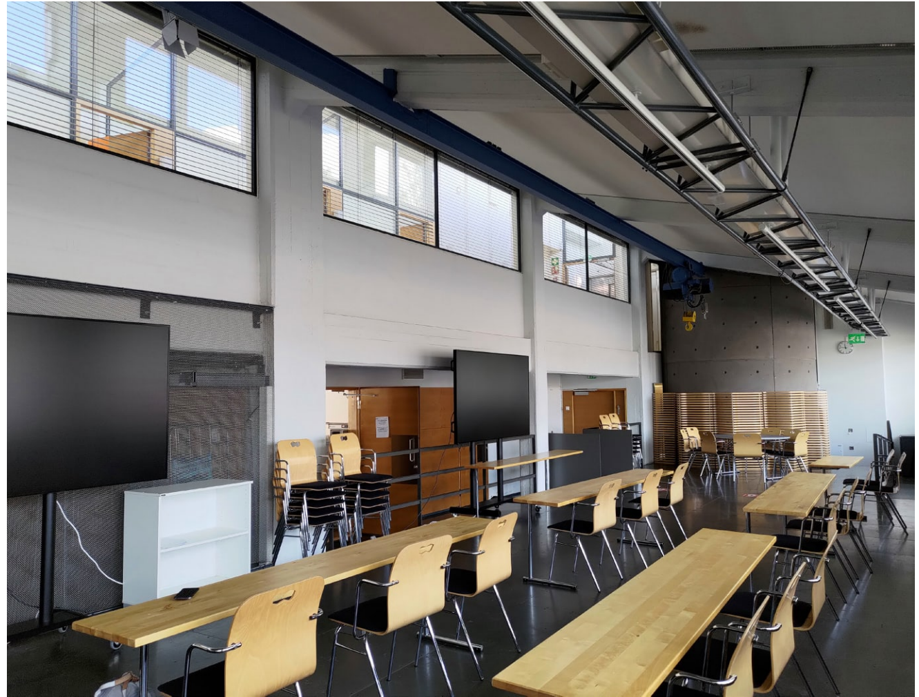
Näkymä samasta kohdasta toukokuussa 2022. Entistä tutkimushallia rajaava pitkä seinä on purettu ensimmäisestä kerroksesta ja korvattu tummalla metallikaiteella sekä teräsverkolla. Vuoden 1975 kuvassa näkyvät ritilällä peitetyt aukot on valettu umpeen ja lattiaa korotettu. Vinssi on säilytetty mutta maalattu sinisellä korostusvärillä, joka toistuu myös porrashuoneessa. Sisäikkunoiden tilalla on välissä ollut umpinainen seinä, mutta nykyinen ratkaisu vastaa paremmin alkuperäistä suunnitelmaa.
