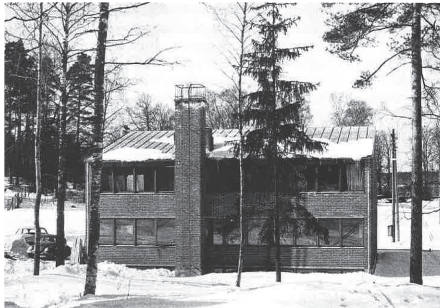
VTT Vuoriteknillisen laboratorion ensimmäinen vaihe valmistui vuonna 1955. Kuva on otettu 1950-luvulla kaakosta. Kuva: VTT:n kuva-arkisto.
