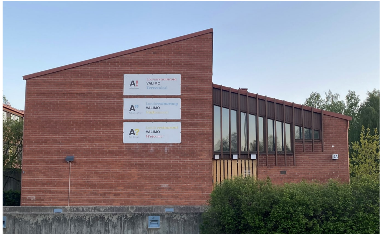
Koillinen julkisivu, sekä betonimuuri ja istutuksia sen edustalla.
