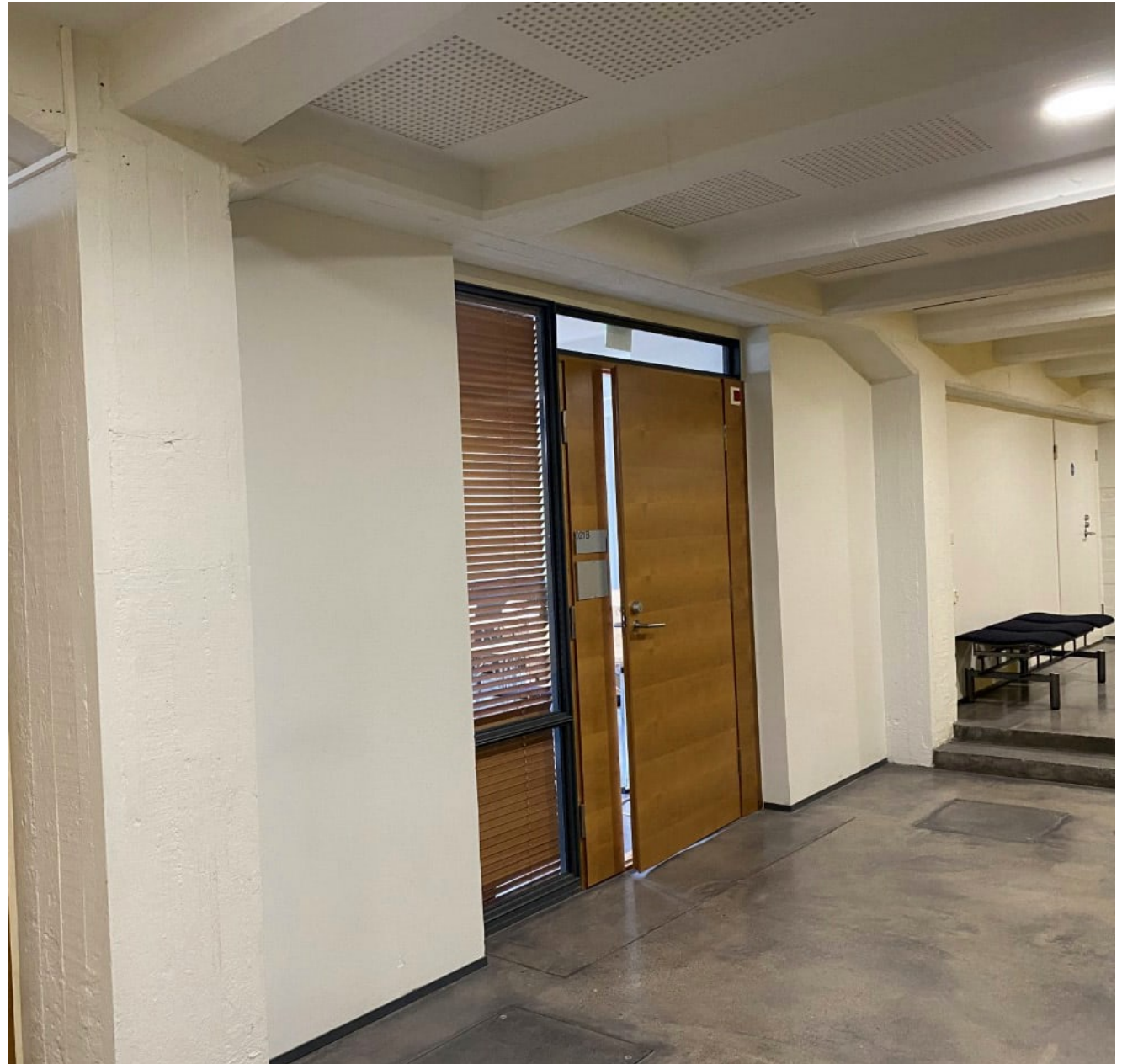
Kellarikerroksen maalattuja teräsbetonipilareita ja palkkeja.
