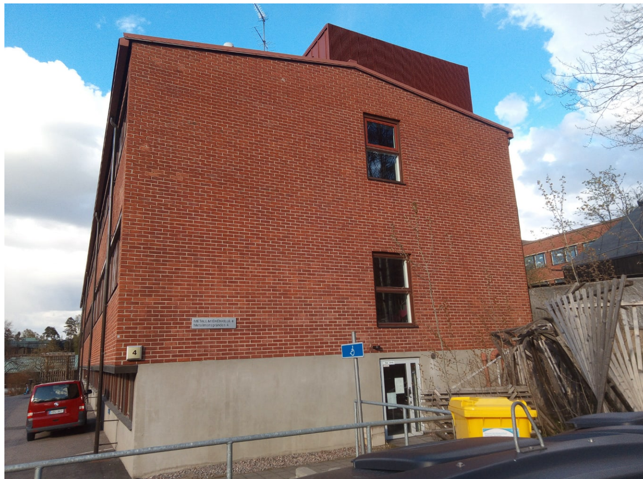
Lounaisjulkisivun ylimmässä ikkunassa on samanlainen punaruskea puite kuin koillisjulkisivulla.
