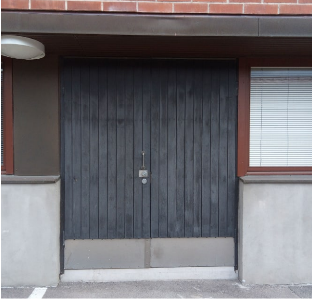
Alkuperäinen luoteisjulkisivun puinen pariovi. Oikealla puolella on muista poikkeava tuuletusikkunaton ikkuna.
