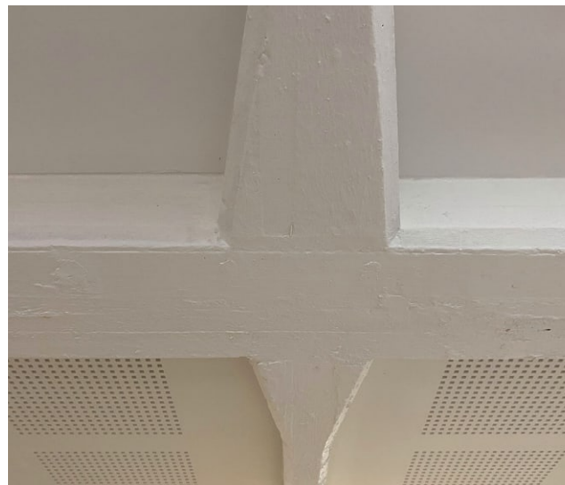
Kellarin sisäkaton ja välipohjan rakenteita.
