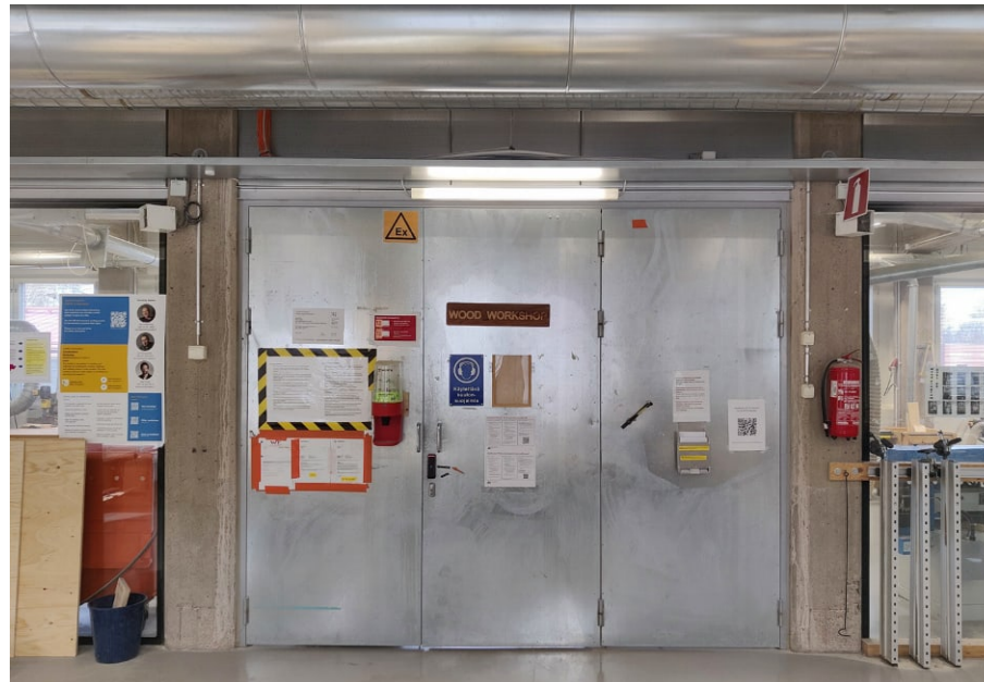
Pajojen ja kokoonpanotilojen väliset teräsovet.
