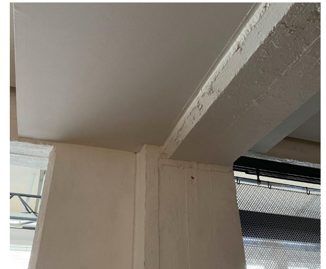
Yksityiskohta ensimmäisen kerroksen pilari-palkki -rakenteesta.
