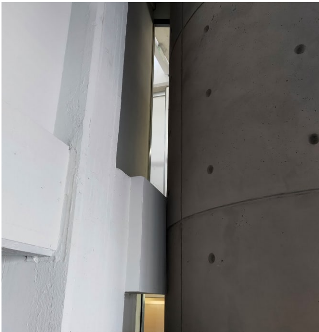
Vuosien 2004–2006 peruskorjauksessa rakennettu kierreportas erottuu monitoimitilan puolella kaarevana, betonisena seinäpintana. Välissä on kapeat sisäikkunat porrashuoneeseen.
