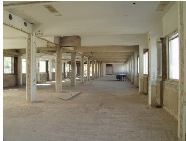
Toinen kerros vanhojen väliseinien purkamisen jälkeen vuonna 2004 tai 2005. Kuva: Jarmo Tiirikainen.
