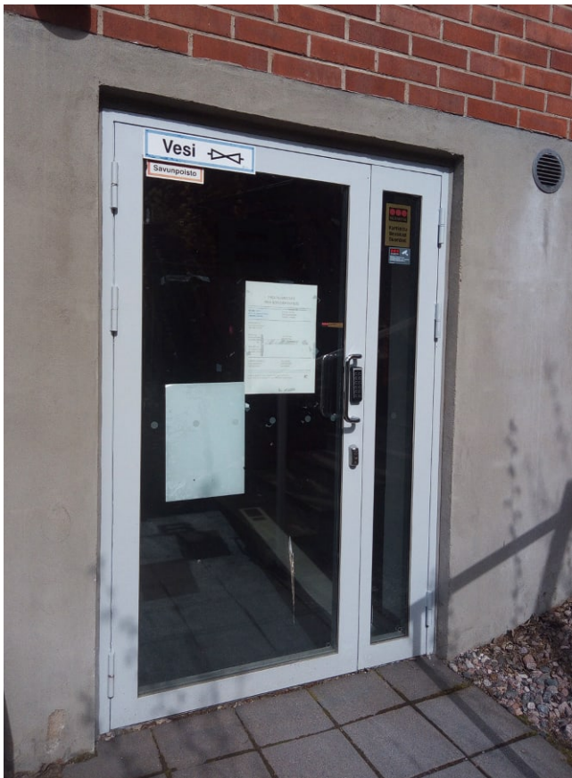
Lounaisjulkisivun teräslasiovi on samanvärisen kuin pääsisäänkäynnin ovet.
