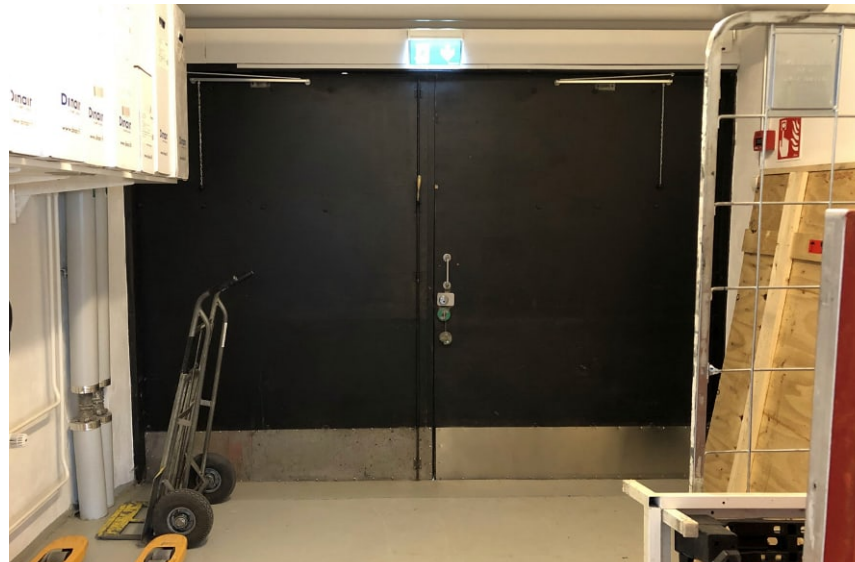
Vanhat kaksoispuuovet tuulikaapissa ovat mahdollisesti alkuperäiset.
