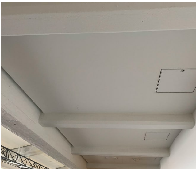
Ensimmäisen kerroksen palkkien väliin on asennettu alakattorakenteita.
