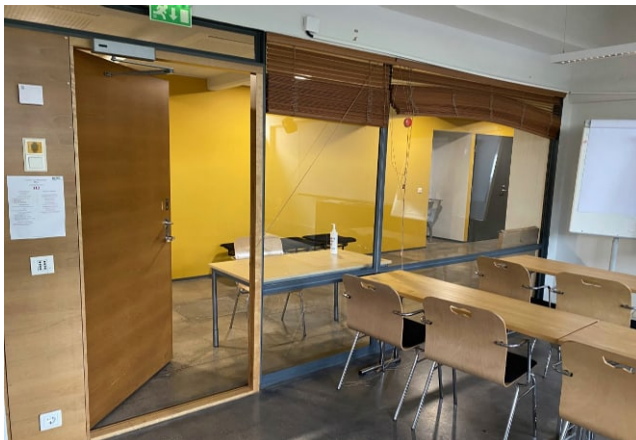
Lasinen väliseinä sosiaalitilojen viereisessä luokkahuoneessa.
