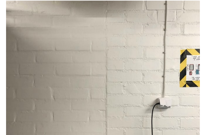
Käytävällä havaittava lounaispuolen seinän muutoskohta näkyy myös seulanvalmistustilan koillisseinällä.
