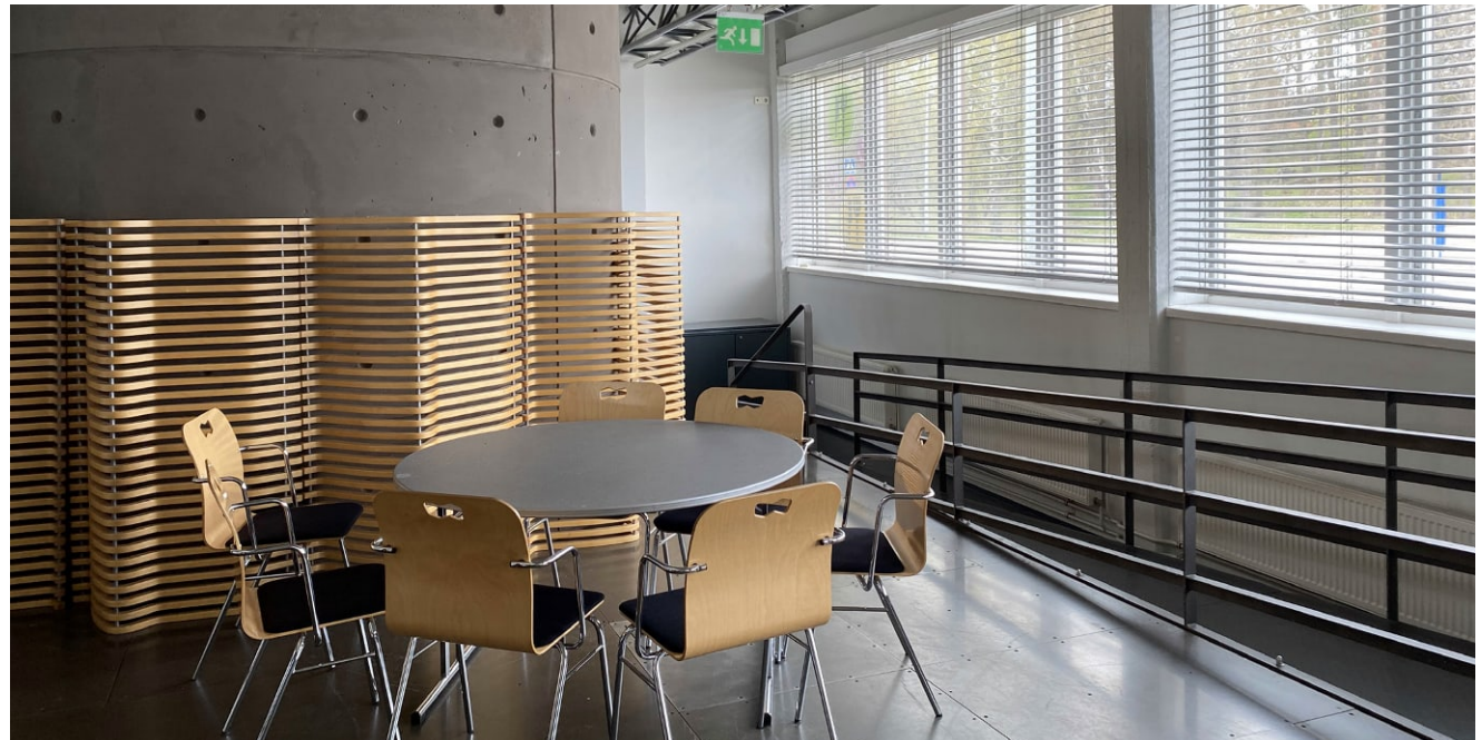
Monitoimitilaan on esteetön yhteys porrashuoneesta metallista kulkuluiskaa pitkin.
