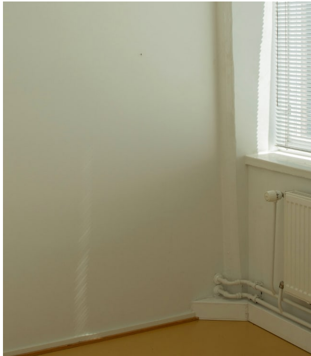
Alhaalta kapeneva pilari rakennuksen alkuperäisessä osiossa.
