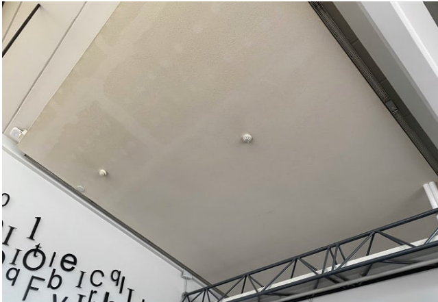
Aulan alakatossa on pitkänmallisten valaisimien reunustamat luonnonvalkoiset akustiset levyt, jotka ovat peräisin vuosien 2004–2006 peruskorjauksesta.
