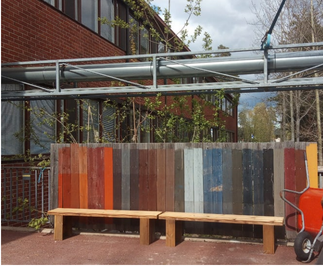
Huoltopihan teräsrakenteita vuodelta 2005.
