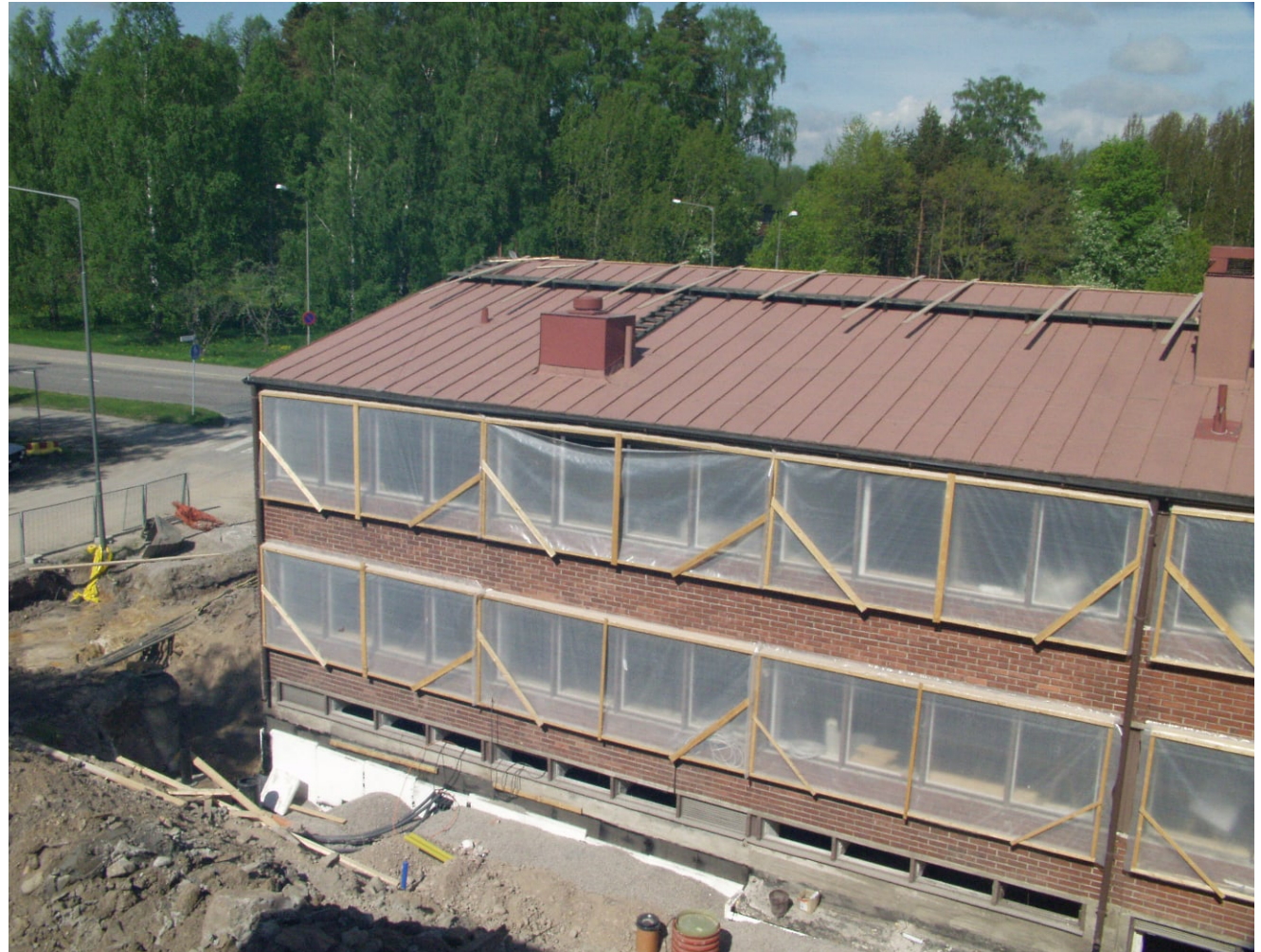
Peruskorjauksen aikaisessa valokuvassa näkyy osa Metallimiehenkuja 2:n kaakkoisjulkisivua. Sokkelia on paljastettu ja ikkunoita peitetty muovilla laajalta alalta. Kuva: Jarmo Tiirikainen 2004–2005 / Jarmo Tiirikaisen yksityiskokoelma.
