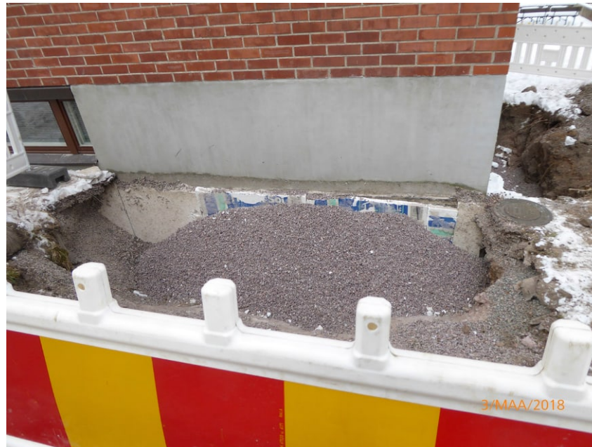
Uuden iv-konehuoneen raitisilman sisäänottosäleikkö toteutettiin vuonna 2018 olemassa olevan nauhaikkunan jatkeeksi, mikä edellytti maastonmuokkausta. Kuva: Rakennuslupa 49-2018-207 / ERakvv.
