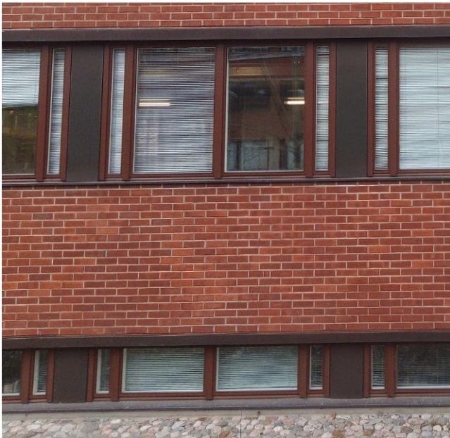
Kaakkoissivun ylempien kerrosten ikkunajako on sama kuin luoteisjulkisivulla. Rinne nousee kaakkoon, joten sokkelikerroksen ikkunat ovat muita matalampia.
