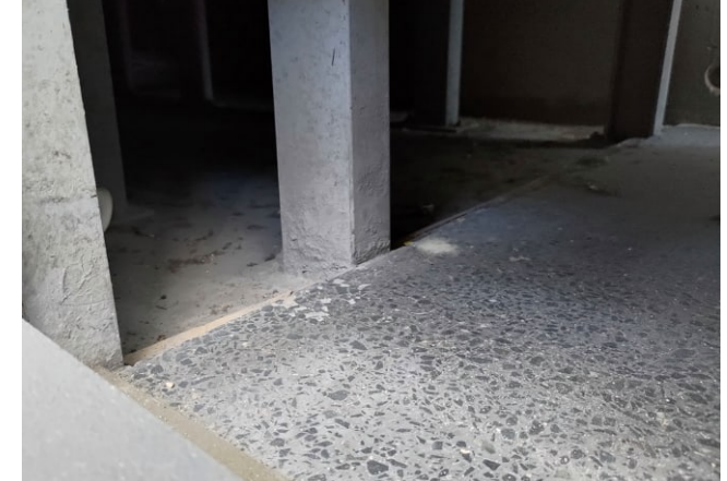
Korotetun lattian alla mosaiikkibetoni vaihtuu raakabetoniksi.
