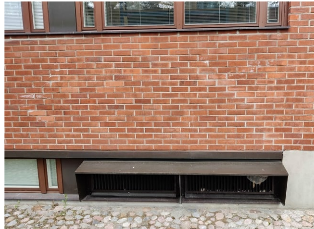
Raitisilmäsäleikkö kaakkoisjulkisivussa vuodelta 2005.
