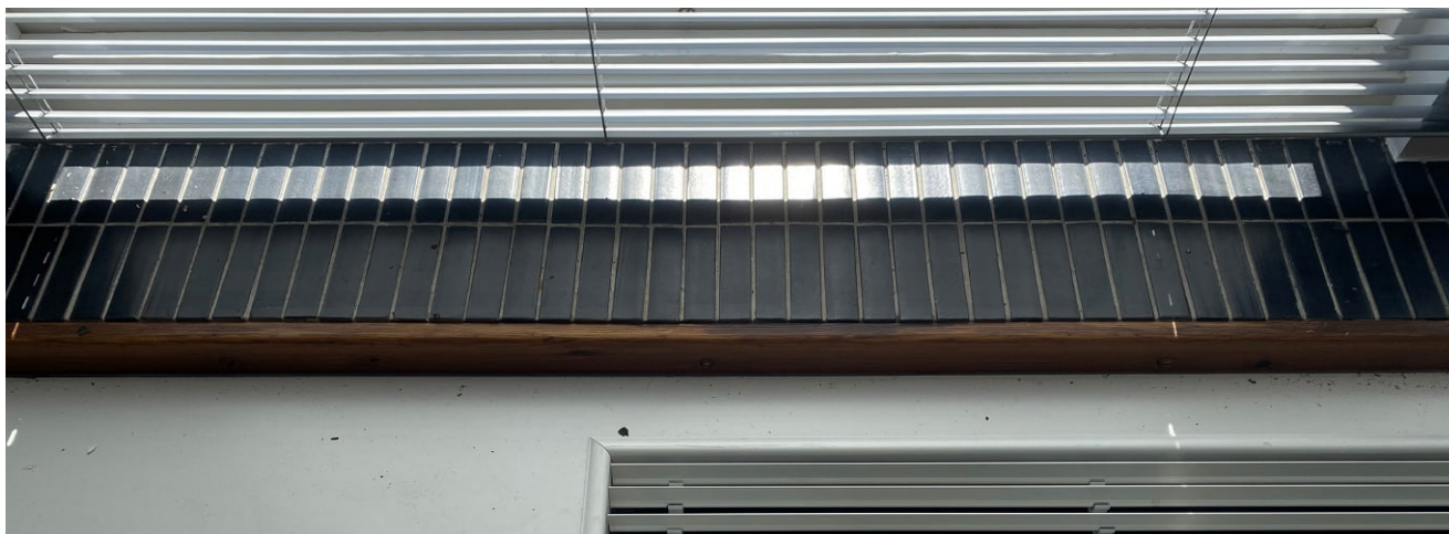
Useissa toisen kerroksen huoneissa on säilynyt alkuperäiset ikkunapenkit, joissa on keraamiset laatat ja puullistat.
