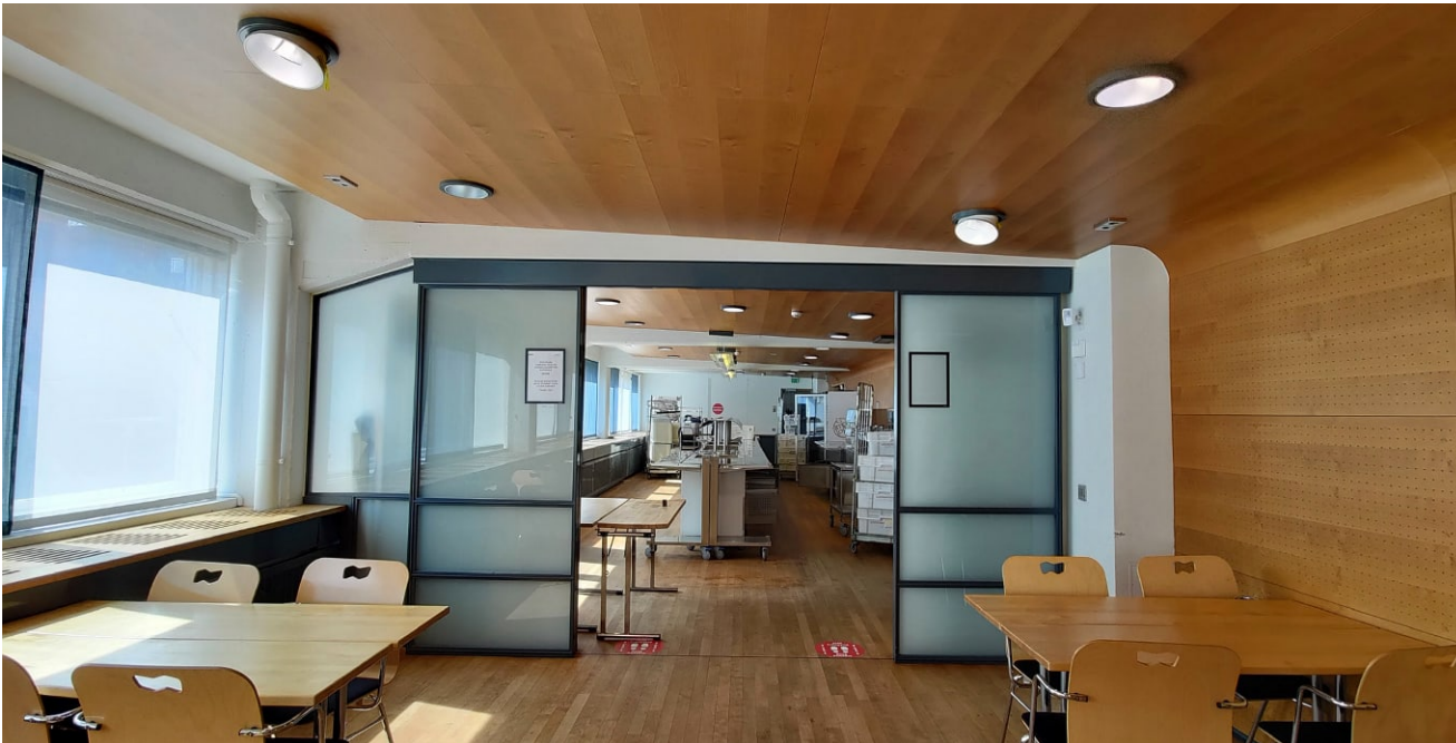
Kattopaneelit on asennettu hieman viistoon ja sahattu muotoon valkoiseksi maalattujen välipohjapalkkien ympäriltä. Paneeleihin on upotettu kaksi riviä pyöreitä valaisimia tasaisin välein. Neuvotteluhuoneiden välinen liukuovi on sovitettu välipohjan palkin kaartuvaan muotoon. Ovessa on teräsrunko ja maitolasit.
