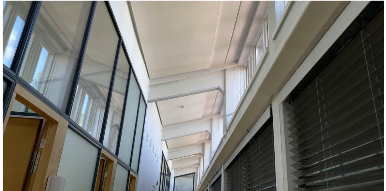
Toisen kerroksen teräsbetoniset kattopalkit.
