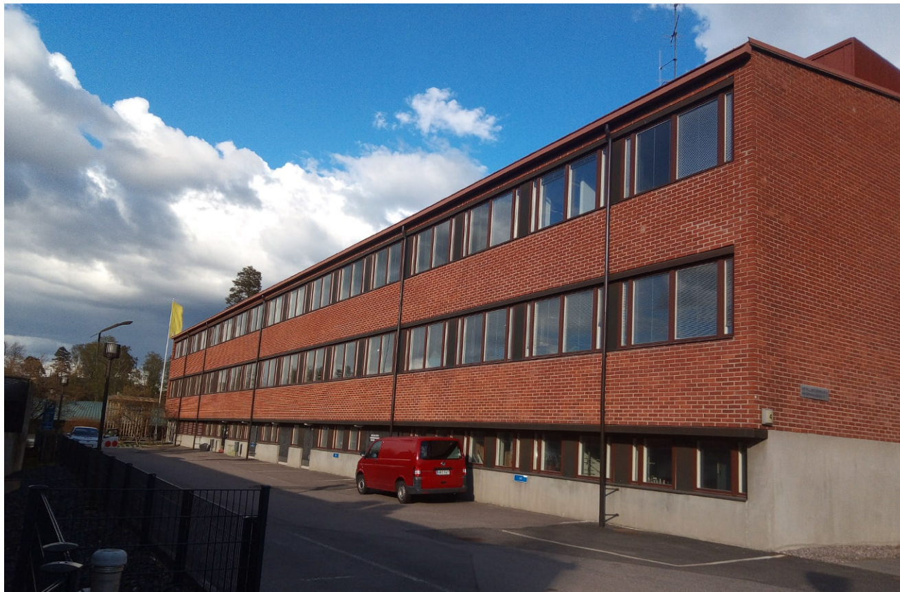
Luoteisjulkisivu kuvattuna länsikulmasta kohti pääsisäänkäyntiä. Kuvasta huomataan, että ensimmäinen kerros on hieman sisäänvedetty. Ensimmäisen kerroksen ikkunat ovat pienempiä ja ruutujako on erilainen kuin ylempien kerrosten nauhaikkunoissa.
