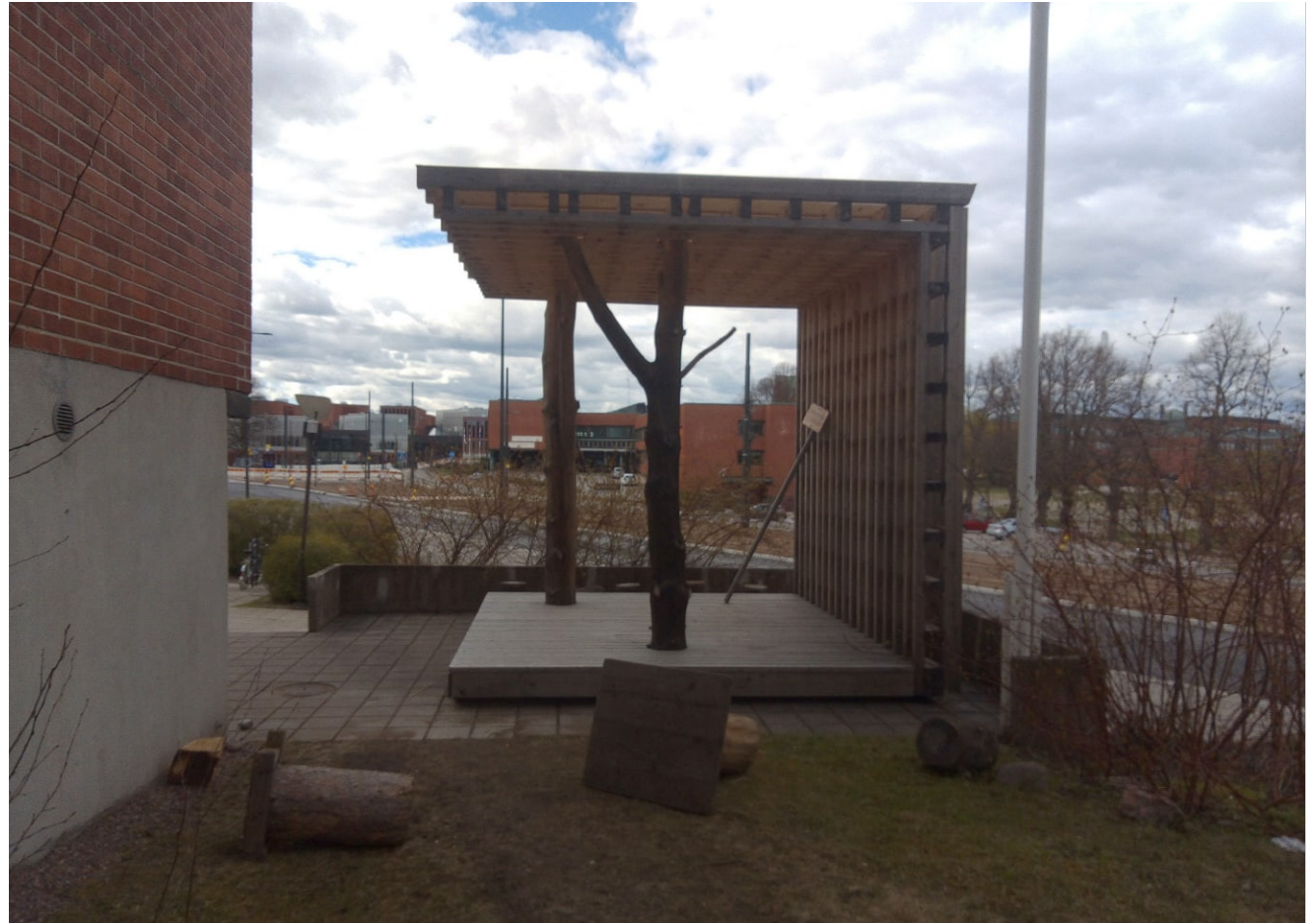
Pääsisäänkäynnin viereinen betonirakenteinen terassi rakennuksen pohjoiskulmassa. 2020-luvun alussa terassille lisätty puinen paviljonki on varsinaisesta terassista irrallinen rakenne.
