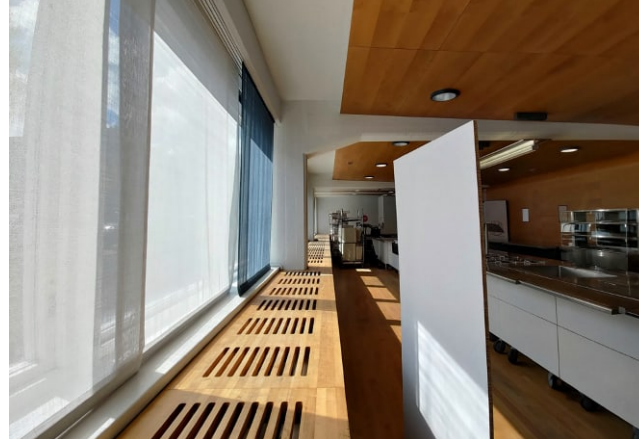
Neuvotteluhuoneiden ikkunat ovat samanlaiset kuin monitoimitilassa, ja niiden alla on peruskorjauksessa 2004–2006 asennetut patterinsuojat. Alakaton paneelit päättyvät samaan linjaan patterinsuojien kanssa.
