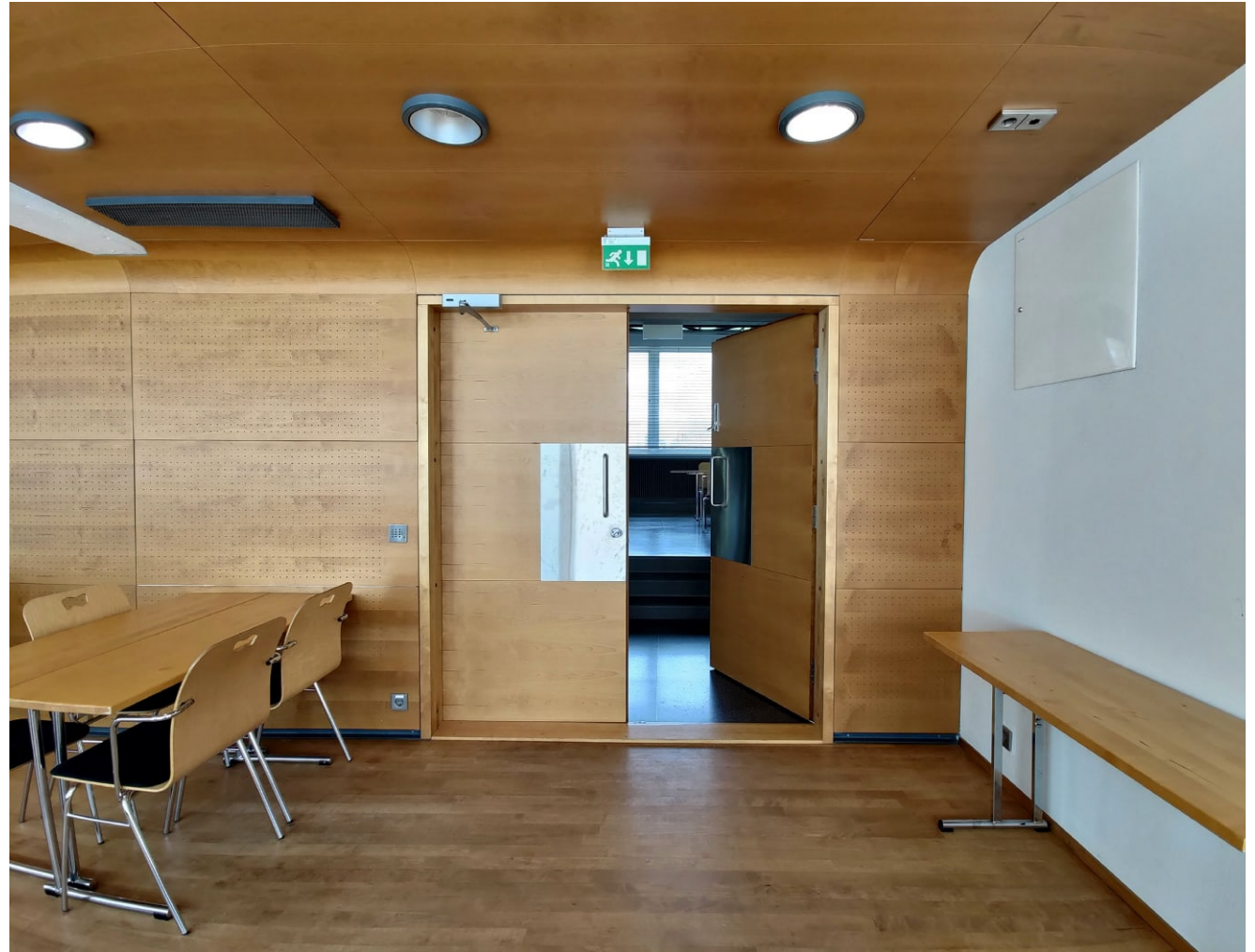
Neuvotteluhuoneita ja keskikäytävää erottaa peruskorjauksessa 2004–2006 rakennettu metallirunkoinen seinä, joka on molemmin puolin verhoiltu rei'itetyillä, puuviilupintaisilla paneeleilla. Myös kaikki neuvotteluhuoneisiin johtavat ovet ovat viilupintaisia. Muut seinät on maalattu valkoisiksi. Kuvassa oikealla näkyvä eteisen vastainen seinä on 1960-luvun laajennuksen aikainen.
