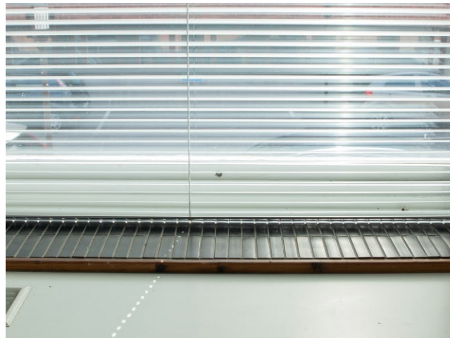
Toimenpide- ja näyttöhuoneen alkuperäinen ikkunapenkki.
