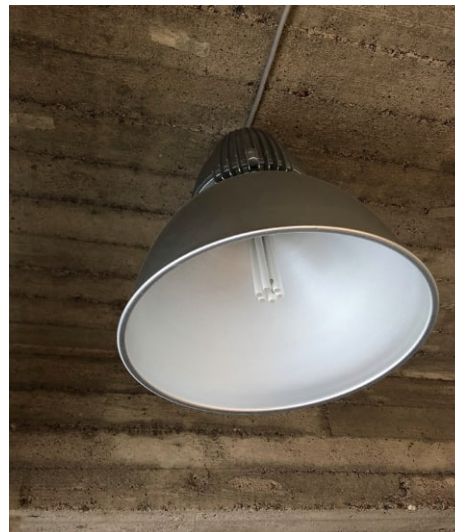
Betonin valumuotin lautakuviointi näkyy selvästi katossa ja palkeissa.
