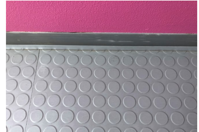
Porrashuoneiden lattioiden, tasanteiden ja porrasaskelmien harmaa, kohokuvioitu matto on vuoden 2005 peruskorjauksesta.
