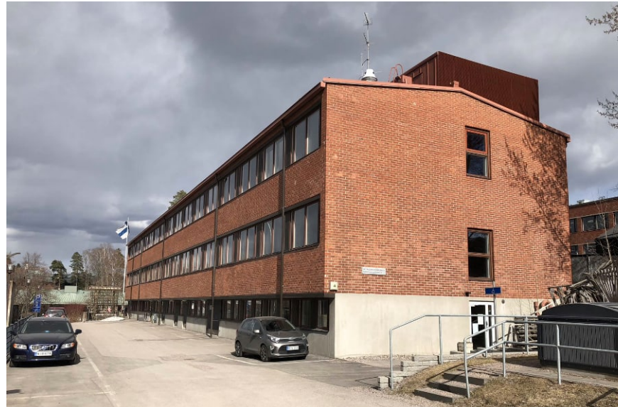
Metallimiehenkuja 4 kuvattuna länsikulmasta. Rakennus edustaa tyypillistä Otaniemen laboratorioarkkitehtuuria. Tyypillisiin piirteisiin kuuluvat punatiilijulkisivu, harmaa betonisokkeli, punainen peltikate, nauhaikkunat tummilla puitteilla ja loiva harjakatto.
