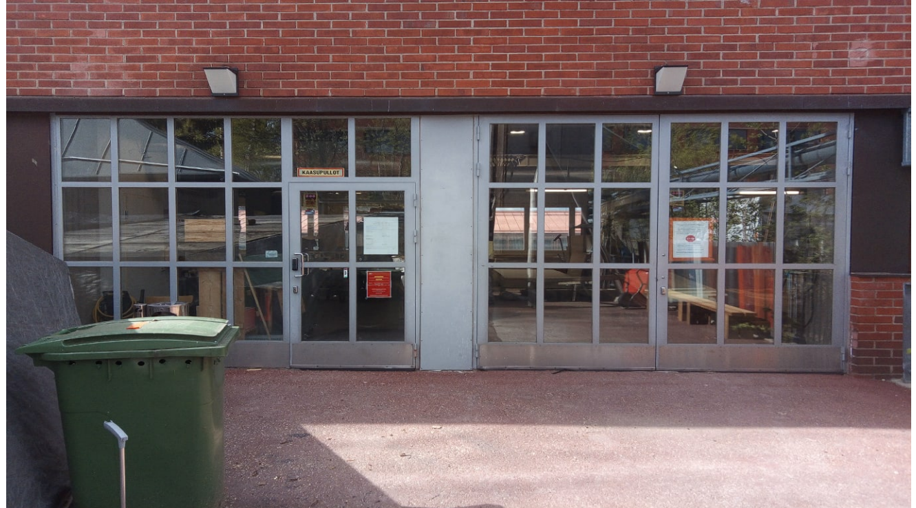
Huoltopihan teräslasiovet ja -seinä ovat vuodelta 2005. Alkuperäiset ovet olivat puisia pariovia.
