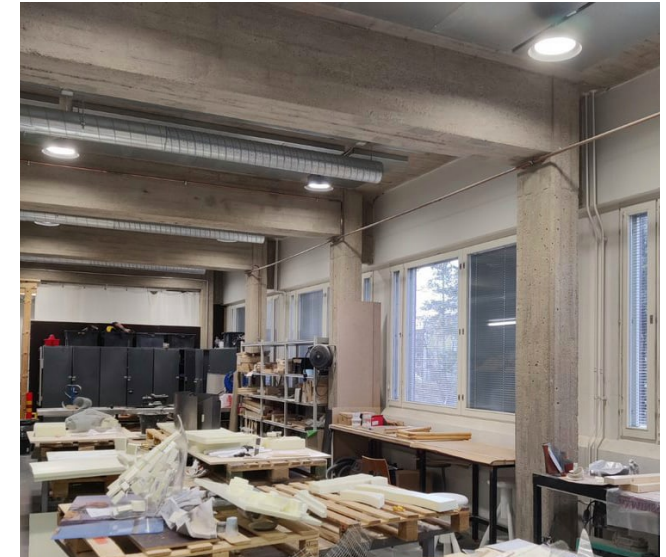
Toisessa kerroksessa teräsbetonipilarit ja palkit ovat paljaita, ilman maalipintaa.
