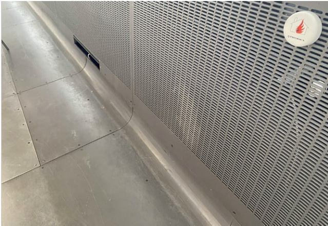
Monitoimitilan korotettu lattia on tummaa metallilevyä, joka kaartuu ikkunaseinän patterinsuojaa vasten.
