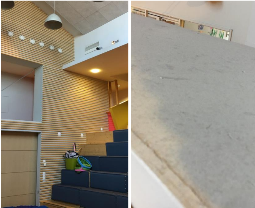
Kuvat 11, 12. Monitoimitilassa H040 on ylätasoja ja tekstiilipintoja, joiden siivous on hankalaa. Mm. oven päällä olevalla tasolla havaittiin runsaasti pölyä (oik).
