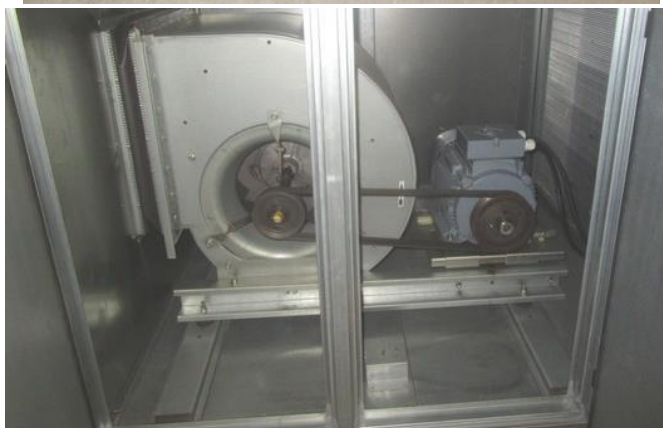
Kuva 19. Koneen TK1 tuloilmapuhallin.
