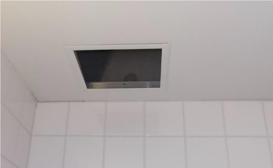
Kuva 4.7. Avonainen tarkastusluukku.
