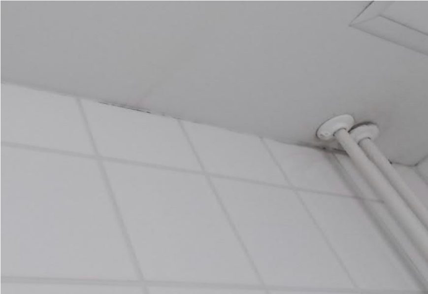
Kuva 4.5. Rakenneliitoksessa ilmavuotoja.
