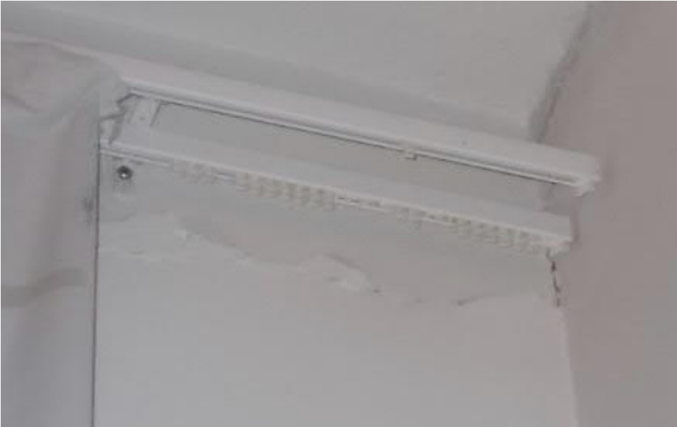
Kuva 4.9. Rakennehalkeama.
