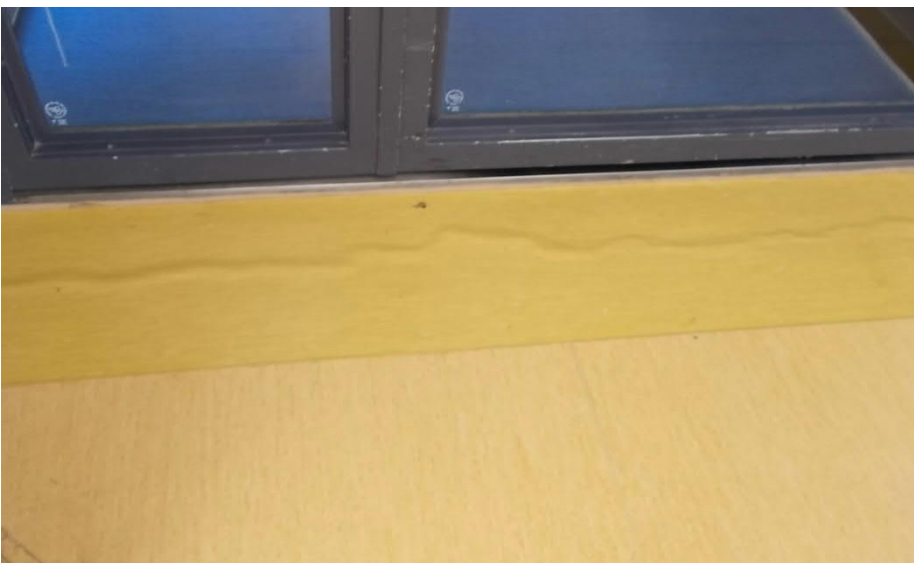
Kuva 4.6. Liikuntasäily lattia- ja ikkunan alla.
