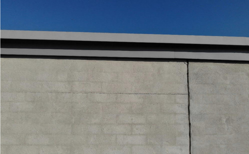
Kuva 4.1. Halkeama julkisivurappauksessa.
