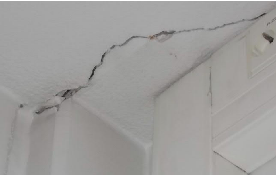
Kuva 4.8. Rakennehalkeama.
