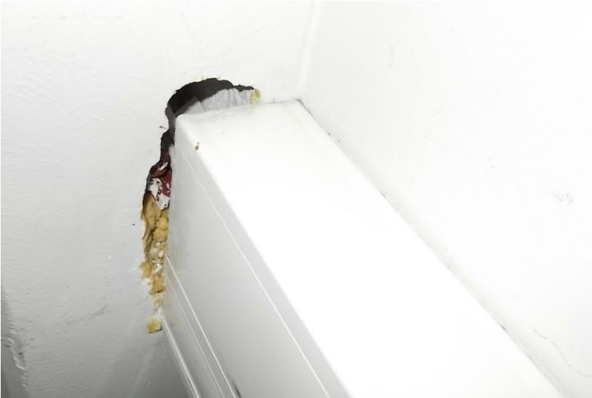
Kuva 4.3. Tiivistämätön läpivienti.
