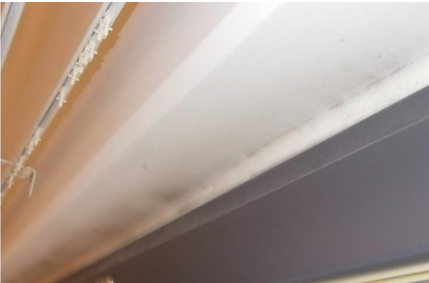
Kuva 4.4. Ilmavuotoja rakenneliitoksessa.
