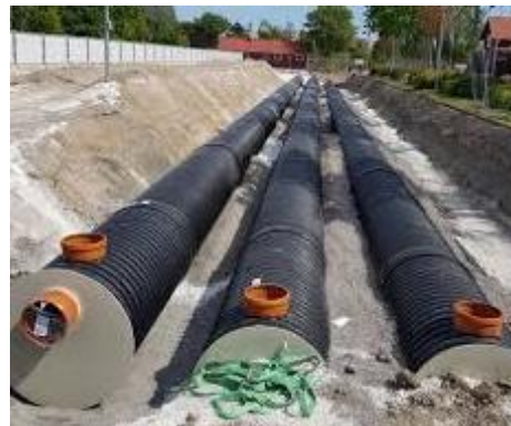
Kuva 4. Esimerkki hulevesitunnelista (Kuva ViaCon) ja viivytysäiliöistä (Kuva Pipelife).
