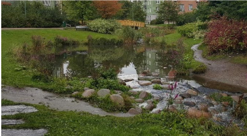
Kuva 2. Esimerkkikuva viivytysaltaasta, jossa biologinen esipuhdistus kasveilla (Kuva Ramboll).
