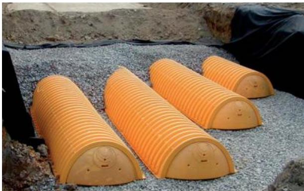
Kuva 4. Esimerkki hulevesitunnelista (Kuva ViaCon) ja viivytysäiliöistä (Kuva Pipelife).
