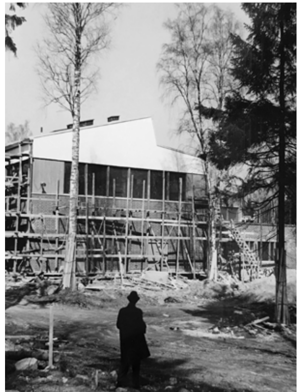
↑↑ Savupiippujen muuraustyöt pääsivät perustustöiden viivästymisen jälkeen käyntiin. VTTA.
