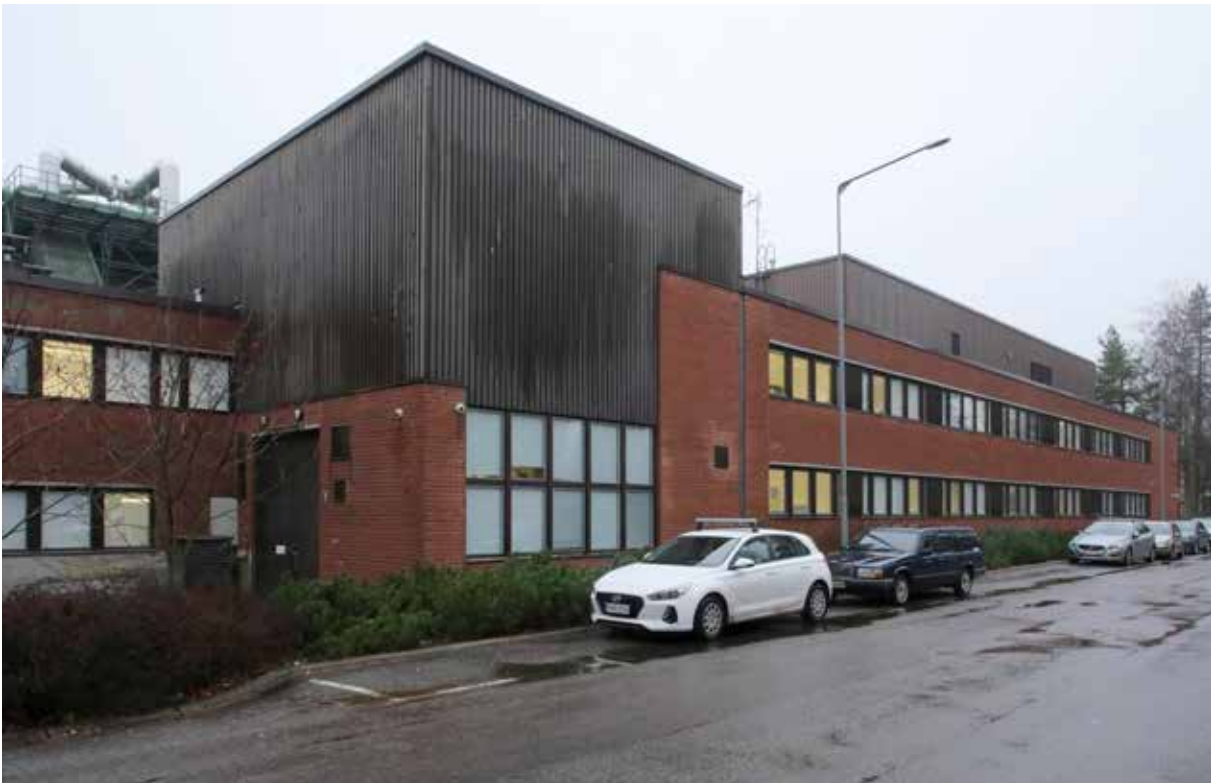
↑↑ Verstassiiven eteläjulkisivu on melko umpinainen. Siipiosa yhdistää uudemman tutkimushallin rakennuksen toimistosiipeen.
