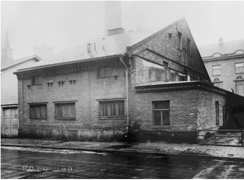
← Paloteknillinen laboratorio Kalevankatu 39:ssä oli entinen tiilinen varastorakennus, joka oli vuonna 1941 kunnostettu VTT:n paloteknillisen osaston laboratoriokäyttöön. Sota-aikana laboratorio oli pääasiassa puolustusvoimien käytössä. VTTA.
