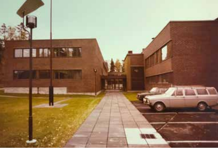
↑ Valmistunut laajennusosa liitettiin ensimmäiseen osaan yhdyskäytävällä. VTTA.
