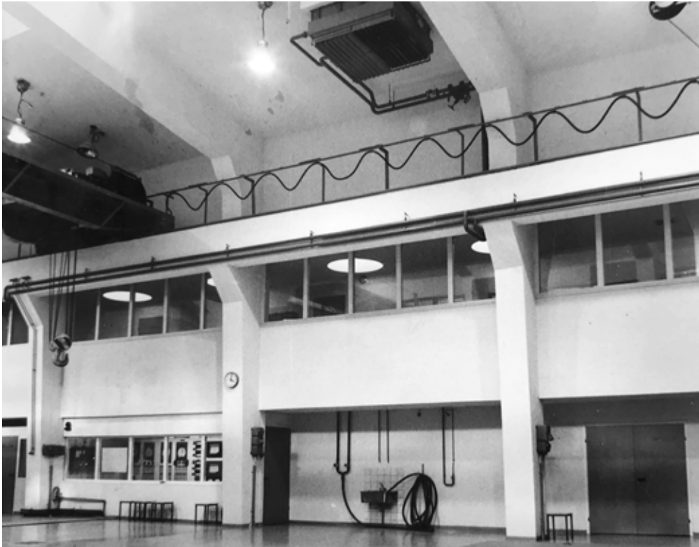
↑ Koepolttohallin betonipilarikehikot olivat vahva elementti tilassa. Yläkerran käytävältä saattoi seurata toimintaa koehallissa. VTТА.
