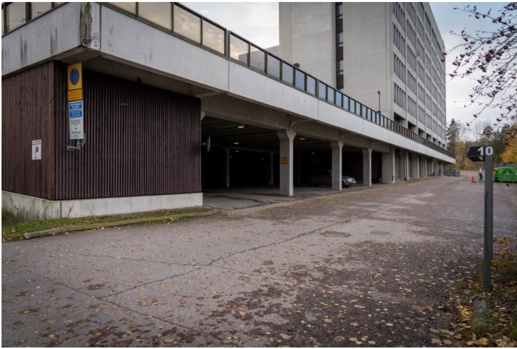
Kutojantie 10:n parkkihalli (kuva: B&M)
