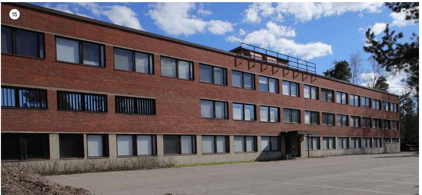
Metallimiehenkuja 6 julkisivu luoteeseen on rakennuksen pääjulkisivu. Punatillistä julkisivua rytmittää pareittain nauhaan sommitellut, tummapuitteiset ikkunat. Mittaushuoneen matalampien ikkunoiden edessä on pystysäleet.
