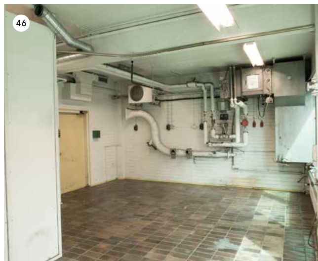
2. kerroksen työskentelytila. Tiloissa on näkyvillä runsasti tekniikka-asennuksia. Lattian laattapinta on alkuperäinen.
