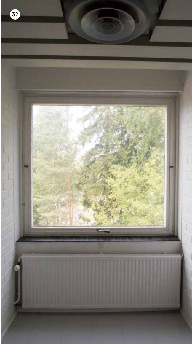
Käytävän päätyikkuna. Ikkunalauta on tummaa klinkkerilaattaa.
