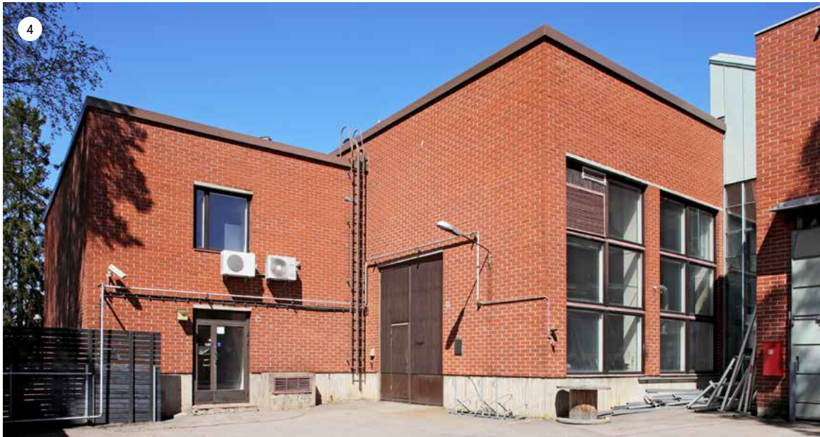
Metallimiehenkuja 6 Konehallin korkea ikkuna-aukutus poikkeaa muun rakennuksen nauhaikkunalinjasta. Laajennusosa peittää osin ikkunat ja ne avautuvat uudemman hallitilan sisään. Hallin sisäänkäyntiovi on umpinainen puupariovi, kun taas porrashuoneen ovi on metallilasiovi.
