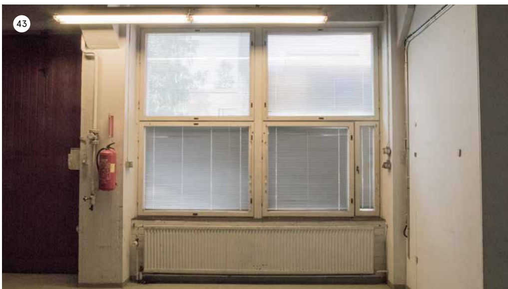
Koneistus- ja suuren hitsaamosalin tyypillinen suuri ikkuna. Osa ikkunoista on peitetty levyillä.
