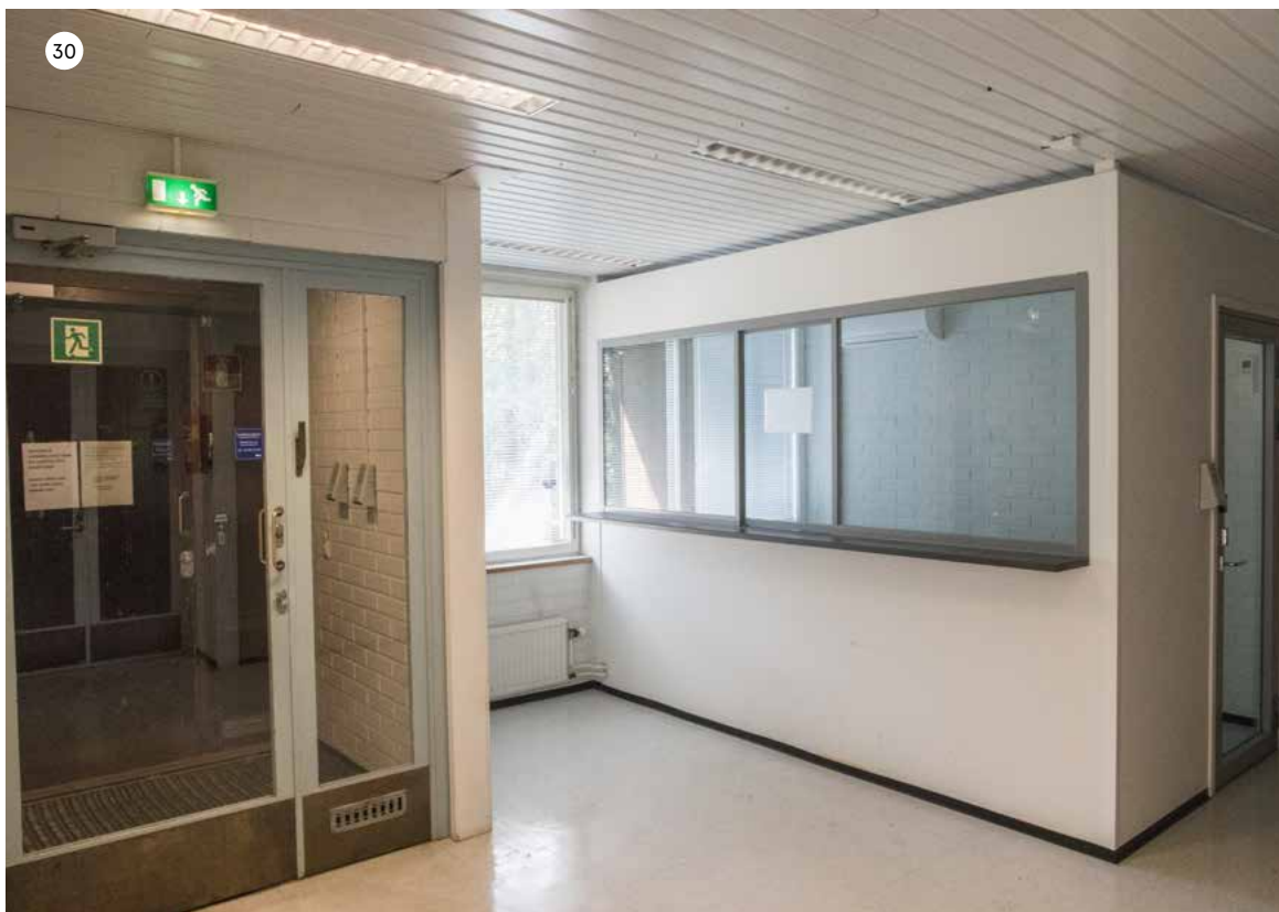
Metallimiehekuja 8 sisääntuloaula. Tilaan on myöhemmin lisätty vahtimestarin työtila ja purettu väliseinä.
