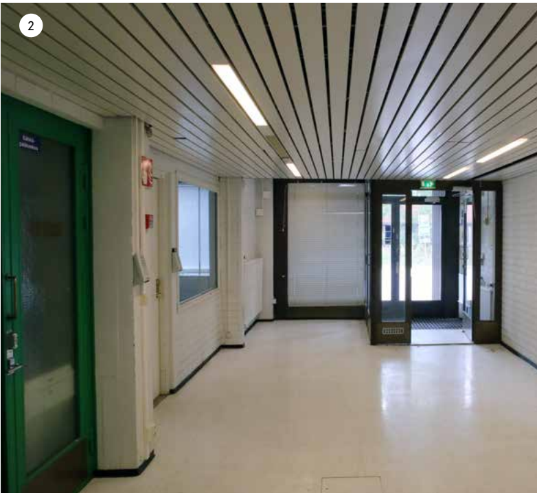
Sisäntuloaulassa 1. kerroksessa on erillinen metalli-lasirakenteinen tuulikaappi. Vasemmalla kuvassa on vahtimestarin tilan ikkuna ja kulkuovi sekä vihreä ovi keskikäytävään.
