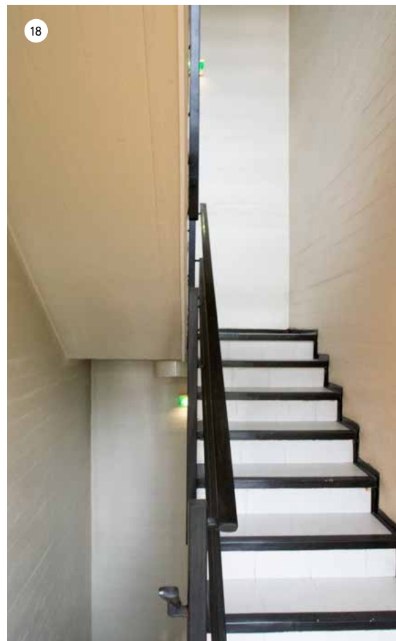
B-porras rakennuksen itäpäädystä on piirteiltään A-portaan kaltainen, mutta kapeampi sekä käsijohde on mustaa muovia.
