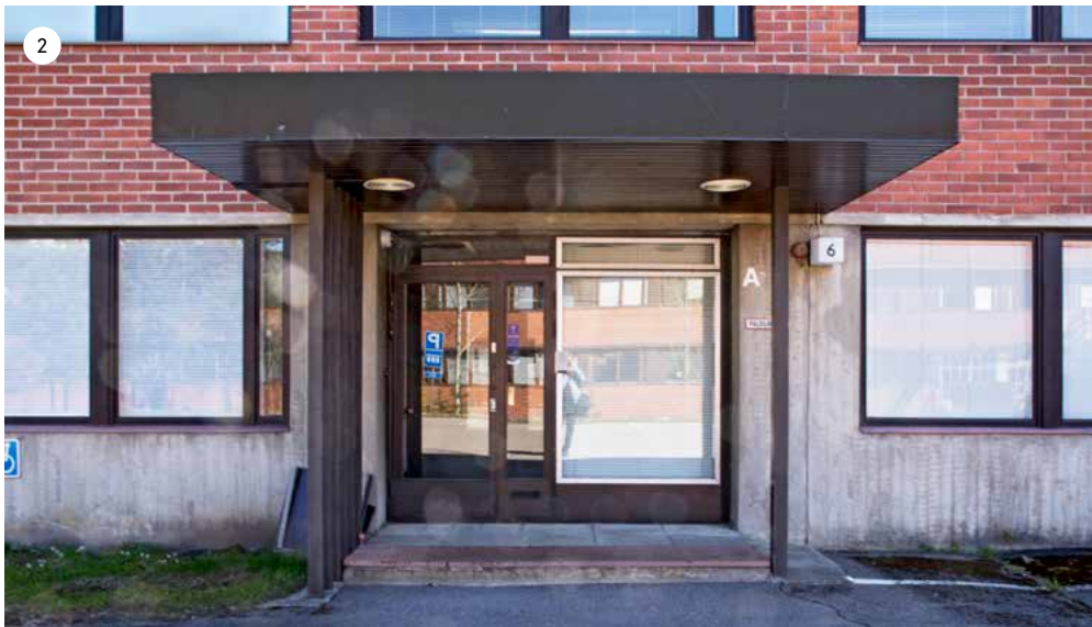
Metallimiehenkuja 6 pääsisäänkänti. Alun perin rakennuksessa ei ollut lainkaan katoksia. Vuonna 1992 rakennettu katos istuu luontevasti paikalleen.
