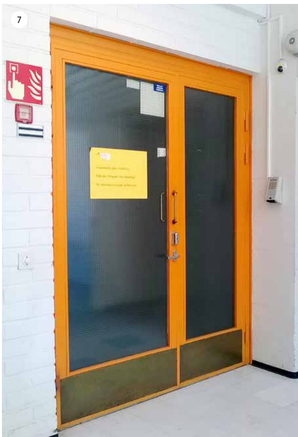
7 Käytävätilojen molemmissa päissä on alkuperäiset metallilasiovet. Kuvassa toisen kerroksen ovi.
