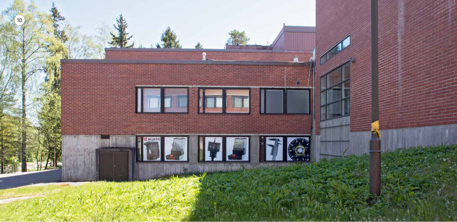
Metallimiehenkuja 8:n luoteisjulkisivu ja laajennusosan koillispäätty.
