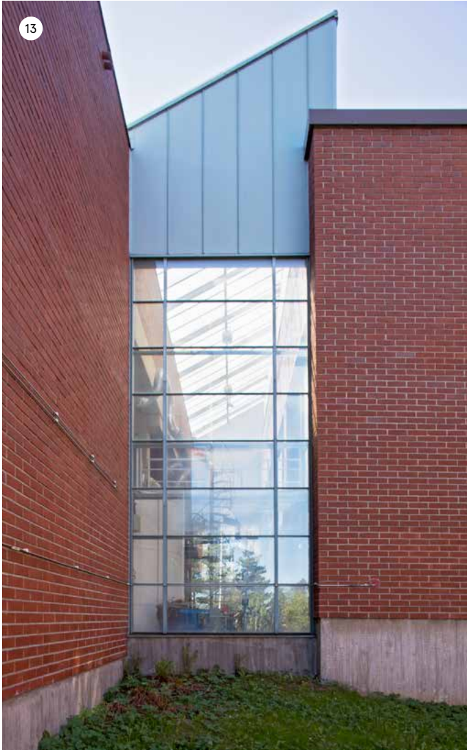
Koehalli 2 lasikatteinen nivelosa yhdistyy alkuperäiseen konehalliin.
