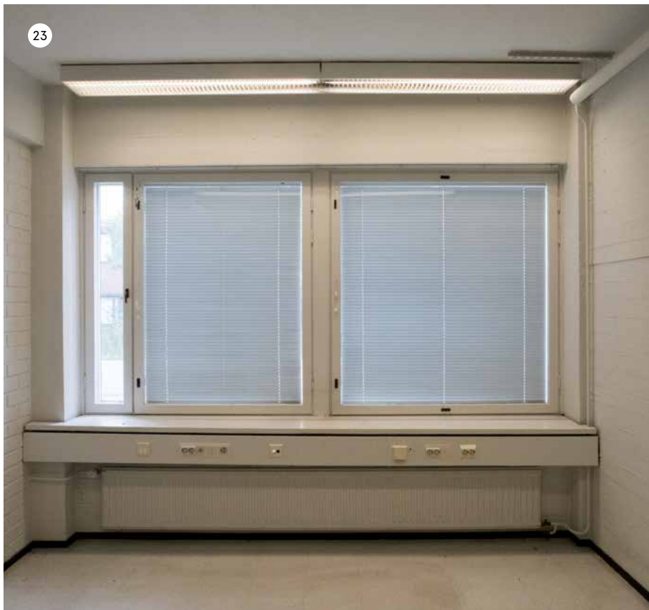
Tyypillinen toimistohuone. Huoneessa on koko huoneen levyinen ikkunapinta ja ikkunalaudan alle on tehty tekniikka-asennuskouru. Loisteputkivalaisin on kiinnitetty suoraan kattopintaan.
