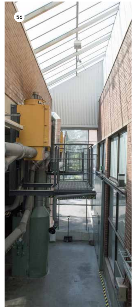
Lasikate Metallimiehenkuja 6 rakennuksen puolelta kadulle päin.
