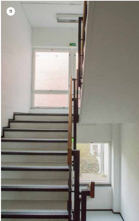
Metallimiehenkuja 6 pääporras A. Lepotasojen kohdalla on sisäpihalle avautuvat ikkunat.
