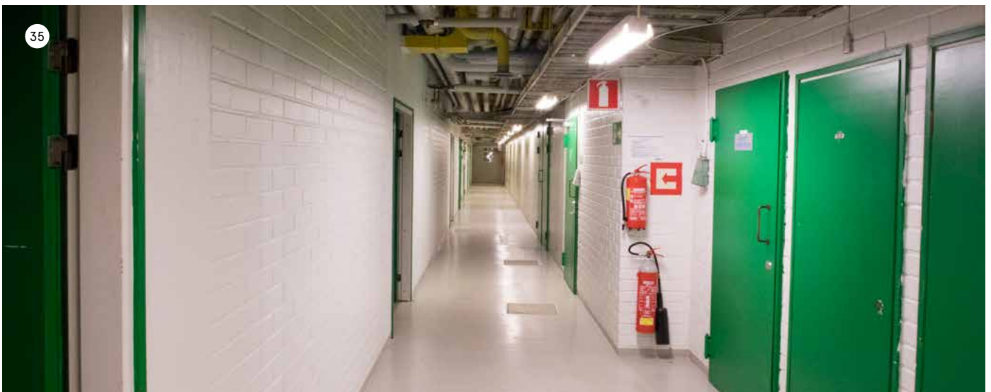
1. kerroksen kellarikäytävässä on säilynyt vihreä teemaväri ovissa sekä käytävän kattopinta on maalattu keltaiseksi. Käytävässä ei ole muista kerroksista poiketen alakattoa vaan tekniikkavedot ovat näkyvissä.
