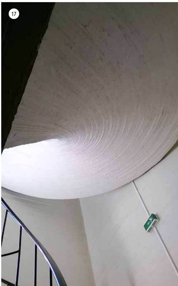
C-portaan ilmeikäs valumuottikuvion betonialapinta.
