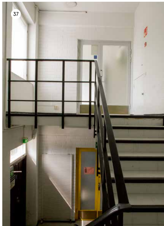
Sivuportaan E ylätasanne rakennuksen länsipäädssä.
