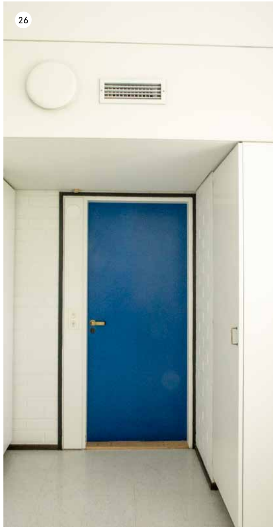
Tyypillinen alkuperäinen kolmannen kerroksen toimistuhuoneen ovi. Sen sivupieleessä kulkee tekniikka-asennuksia ja ovea kiertää tumma puulista. Huoneen etuosassa on alaslasku.
