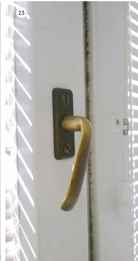
Alkuperäinen tuuletusikkunan kiintopainike.
