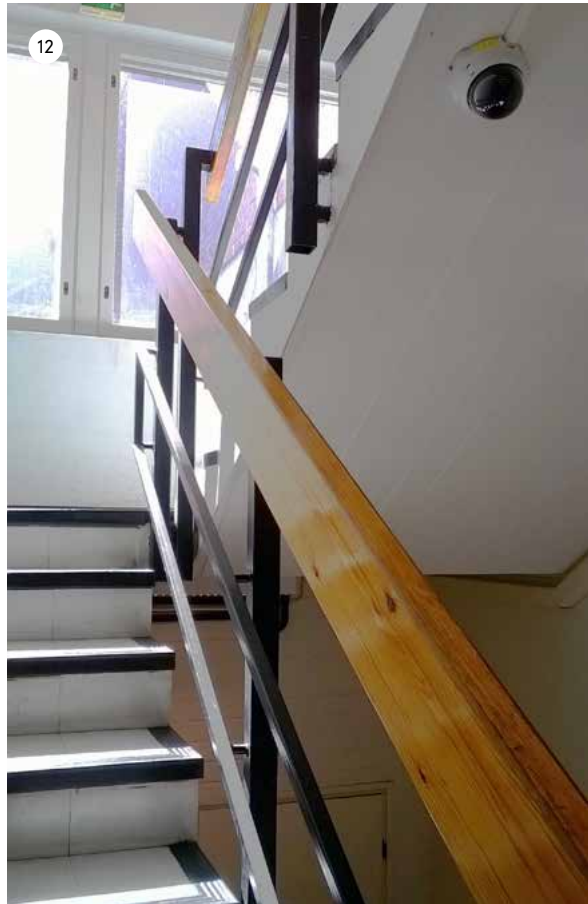
Portaassa on mustaksi maalattu metallikaide sekä lakattu, puinen käsijohde.
