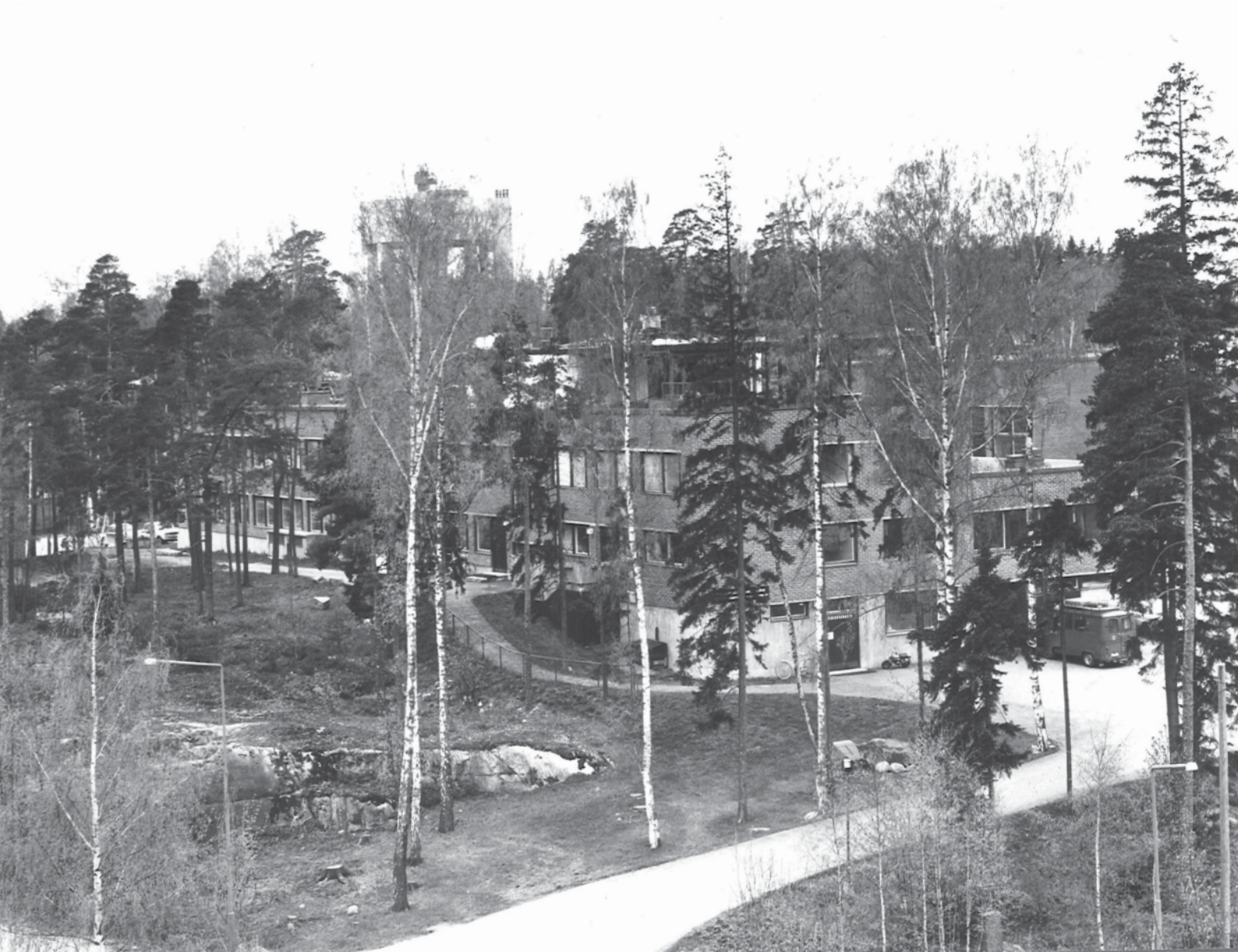
Metallimiehenkuja 6–8 sisääntulotie Otaniementien ja Lämpömiehentien puolelta vuonna 1977. Taustalla näkyy Otaniemen vesitorni. VTT.
