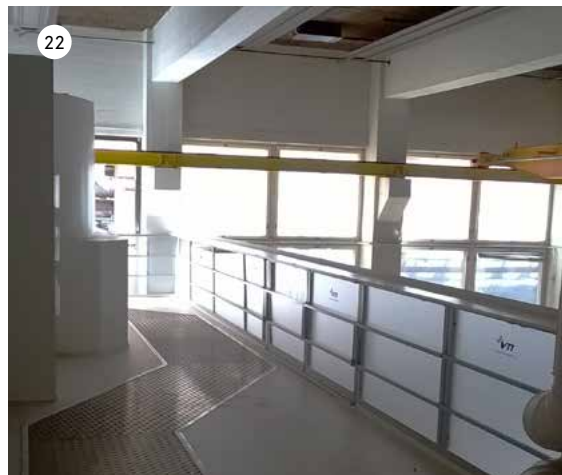
Hallin itäpäädyssä on suurempi parvi josta on myös yhteys laajennusosaan. Kattopalkkien välissä on ruskeaksi maalattuja puukuituisia akustiikkalevyjä.
