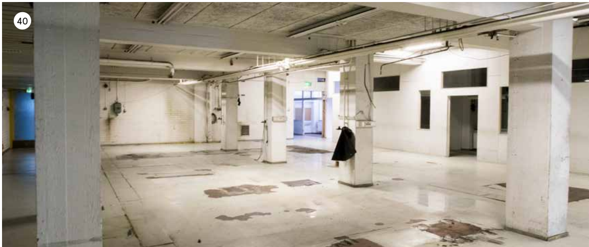
Betonipylväikkö rytmittää koneistushallin tilaa. Hallin pääikkunoiden edustalle on rakennettu levyrakenteinen koppi.
