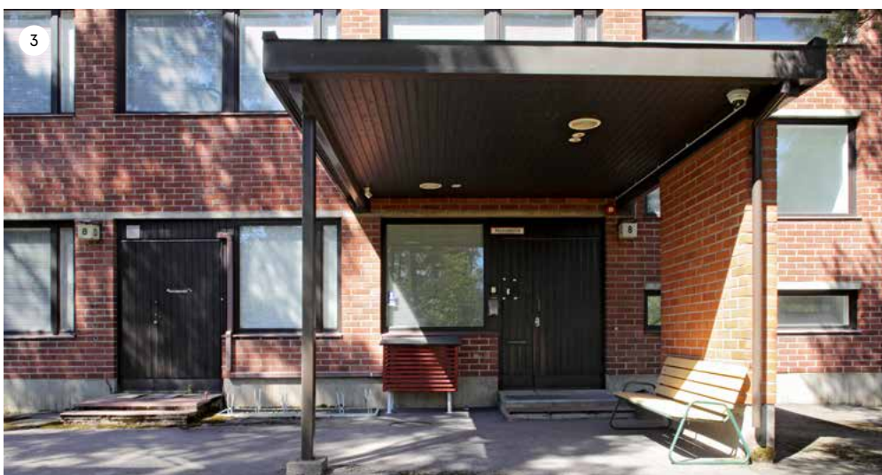
Metallimiehenkuja 8 pääsisäänkäynti ja vuonna 1990 rakennettu katos.
