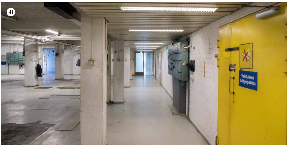
Koneistushallin takaosassa kulkee pilarien rajaama keskikäytävälinja, jossa on alkuperäinen metallisälealakatto.
