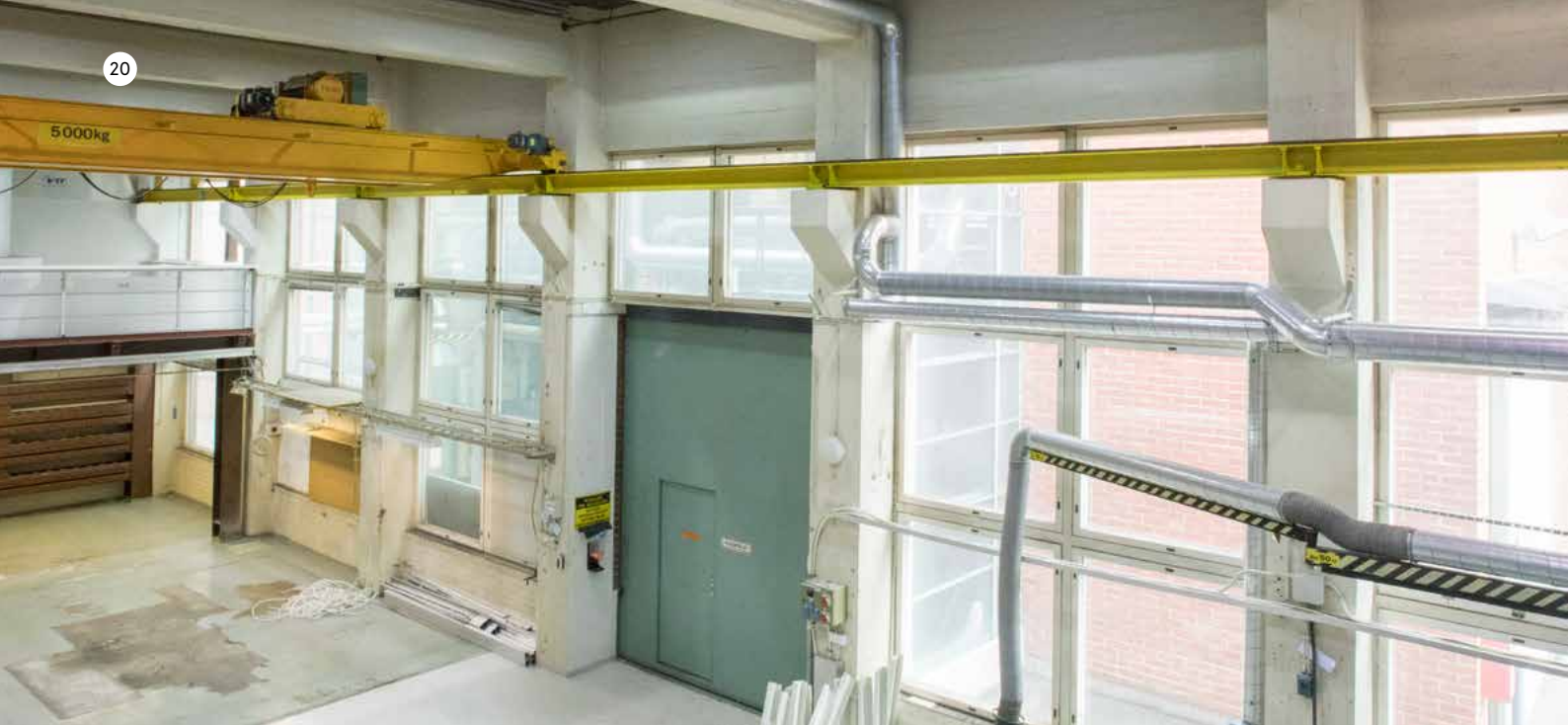
Konehallissa on laajat ikkunapinnat, jotka avautuivat ennen rakennusten väliselle sisäpihalle. Laajennuksen yhteydessä seinään on lisätty vihreä metalliovi ja suurin osa ikkunoista avautuu laajennusosan puolelle.
