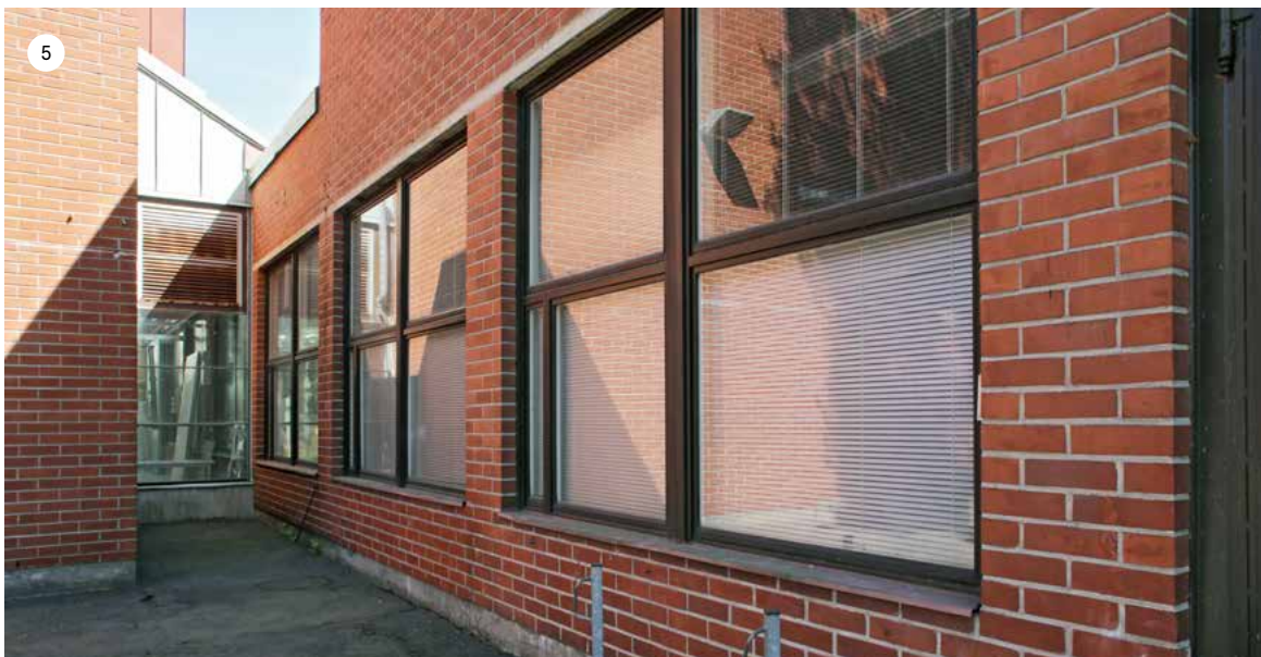
Metallimiehenkuja 8 hitsaushallin suuret ikkunat. Nelijakoisen ikkunan yksi ruutu on jaettu kapealla tuuletusikkunalla. Uudisosa yhdistyy vanhaan viistokatteisen lasi-metallinivelen avulla
