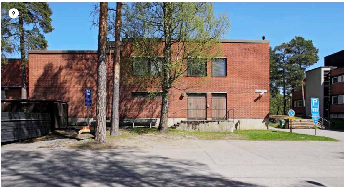
Katunäkymä Metallimiehenkuja 8, lounaispäädyn puuoviset sisäänkäynnit. Etualalla on autopaikoitusta.
