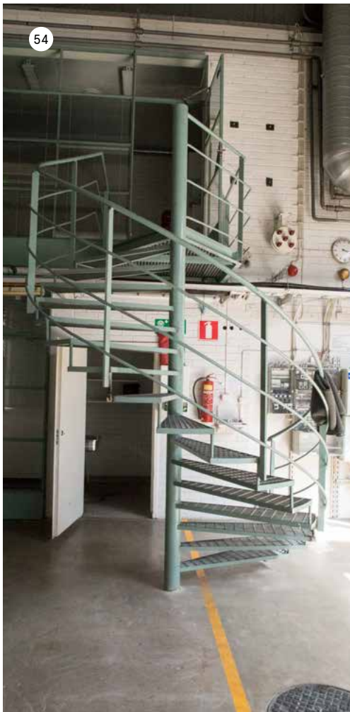
Takaseinän lasiseinäiselle parvelle johtaa vihreäksi maalattu metallikierreporras.
