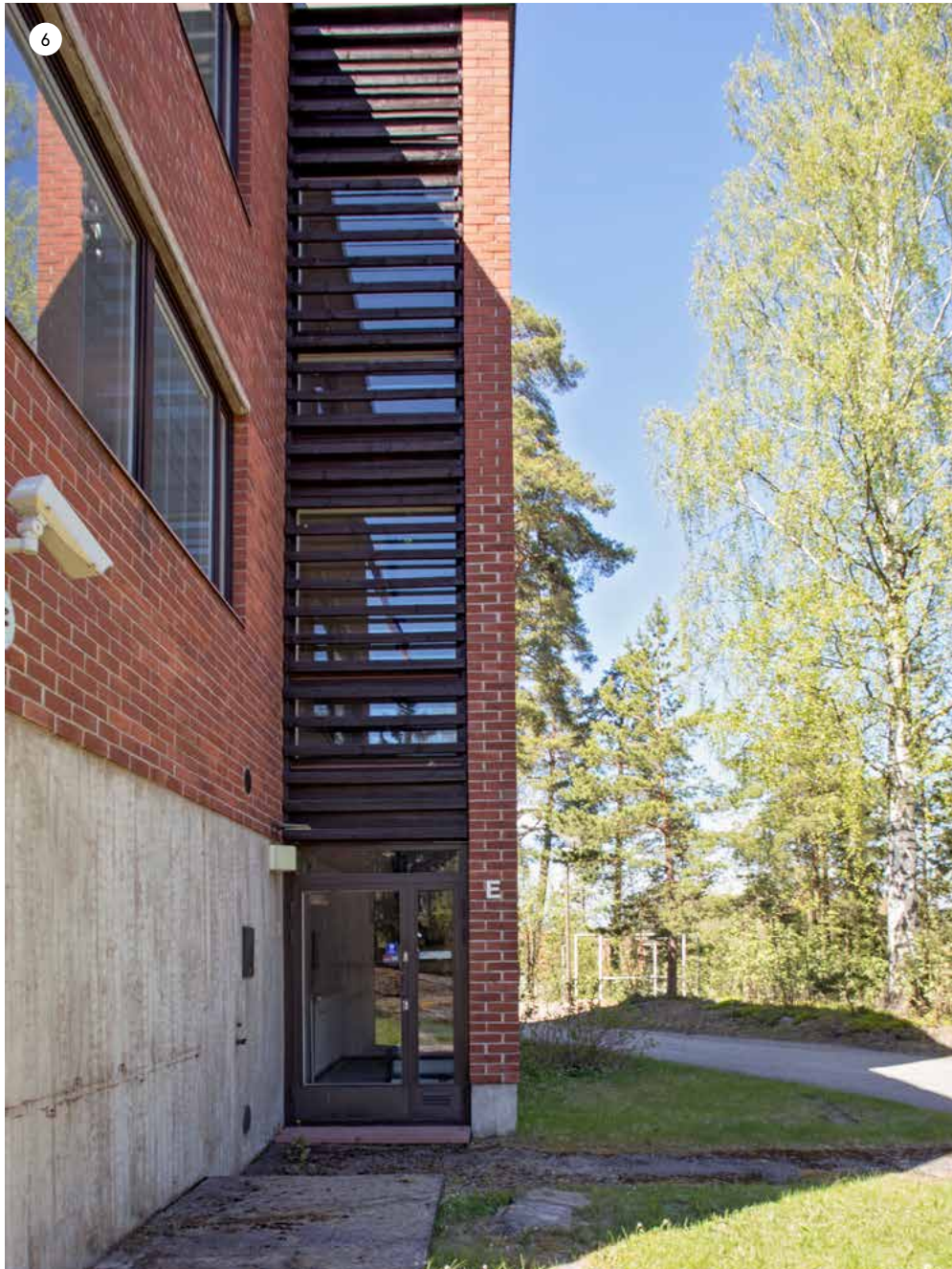
Metallimiehenkuja 6 koillispäädyssä sijaitsee porrashuone, jonka ikkunoiden edessä on käytetty jälleen puusäleaihetta.
