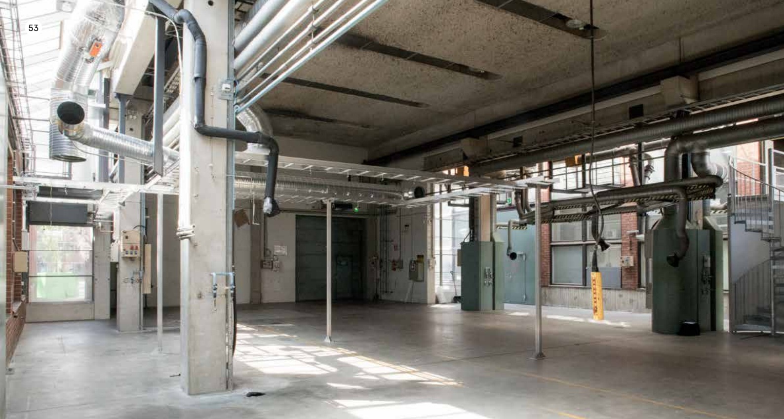
Koehalli kuvattuna Metallimiehenkujalle päin. Kattopinta on ruiskumaalattua ontelaattapintaa, jossa on kapeita, pitkiä aukkoja. Tilaa rajaa betonipilarit.
