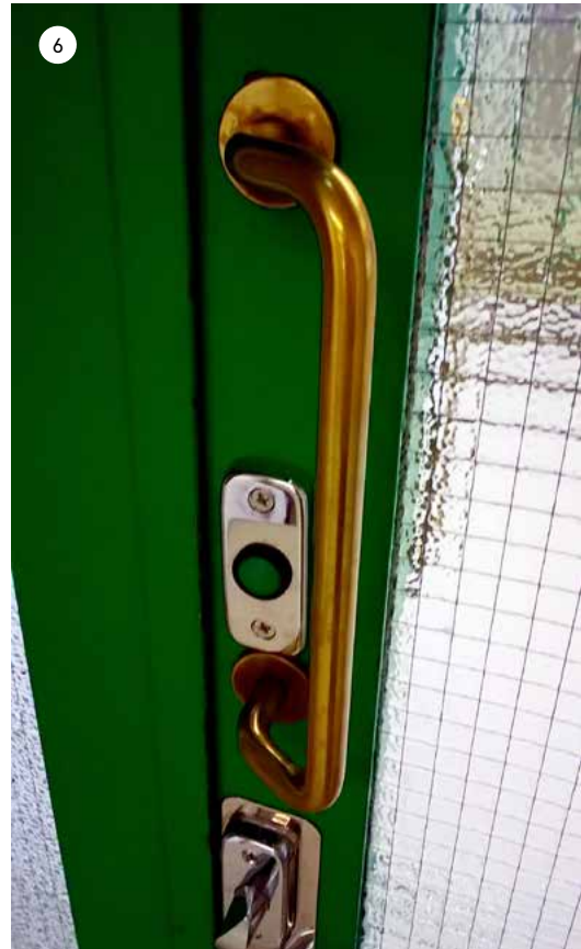
6 Käytävän metallilasioven messinkivedin on alkuperäinen. Lukot on uusittu.
