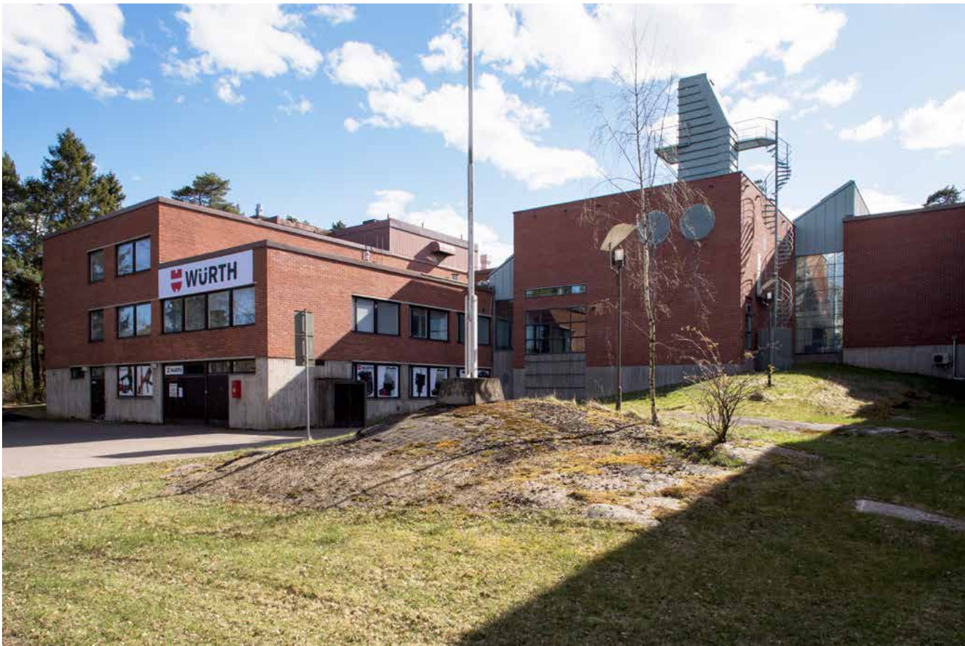
Metallimiehenkuja 6–8 sisäpiha. Vasemmalla sijaitsee vuonna 1970 rakennettu Kojetekniikan laboratorio ja oikealla vuoden 1987 koehalli 2 laajennusosan julkisivut valolyhtyineen.
